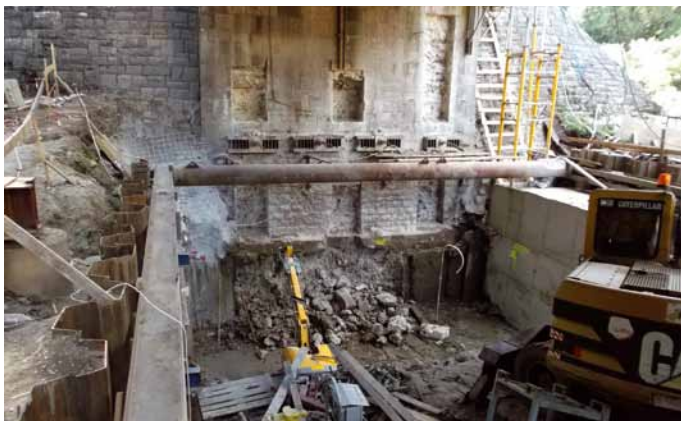
Monolit és előregyártott ágyazatmegtámasztó falszerkezet a térfallal a híd fő tetején
