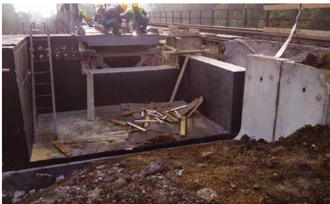
Monolit és előregyártott ágyazatmegtámasztó falszerkezet a térfallal a híd fő tetején
