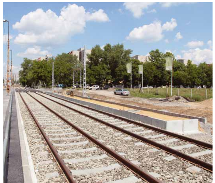
Fehér úti zúzottköves pályaszakaszon már csak a peronépítés és felsővezeteki munkák vannak hátra.
