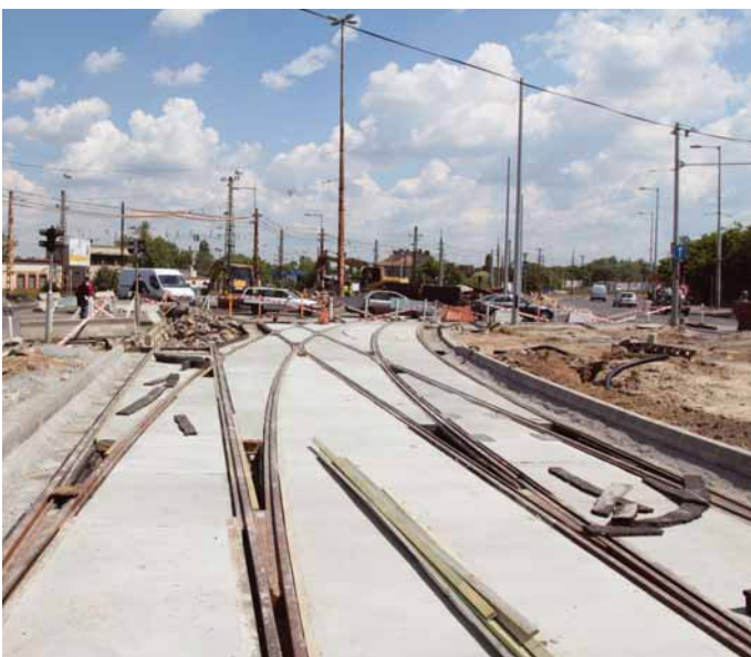
Befejezéshez közel az Éles sarok 3-as, 28-as, 37-es villamosok kitérő és átszelés komplexuma.
