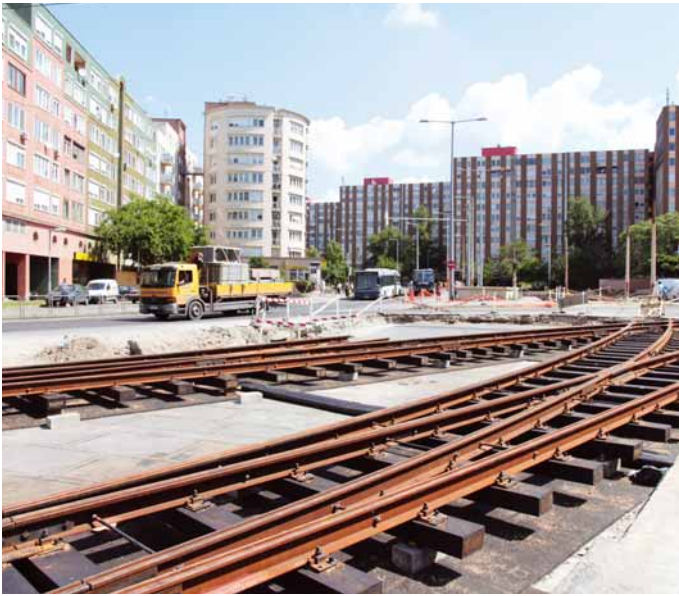
Kápolna utcai kiágazás-kitérők és átszelések betonozás előtt a leszigetelt aluljáró földemen.
