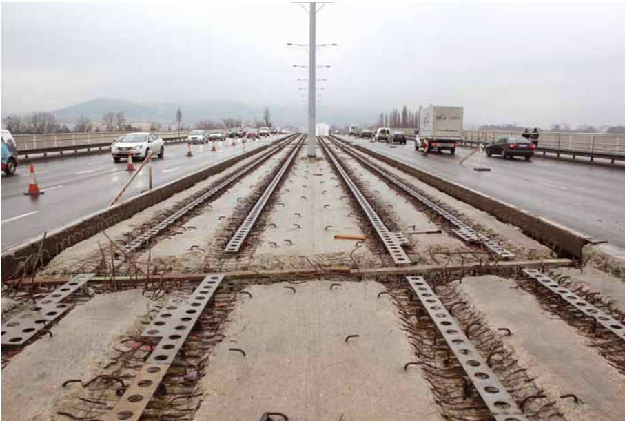
4. ábra: A visszabontott pályalemez a kibontott sínvályúkkal
