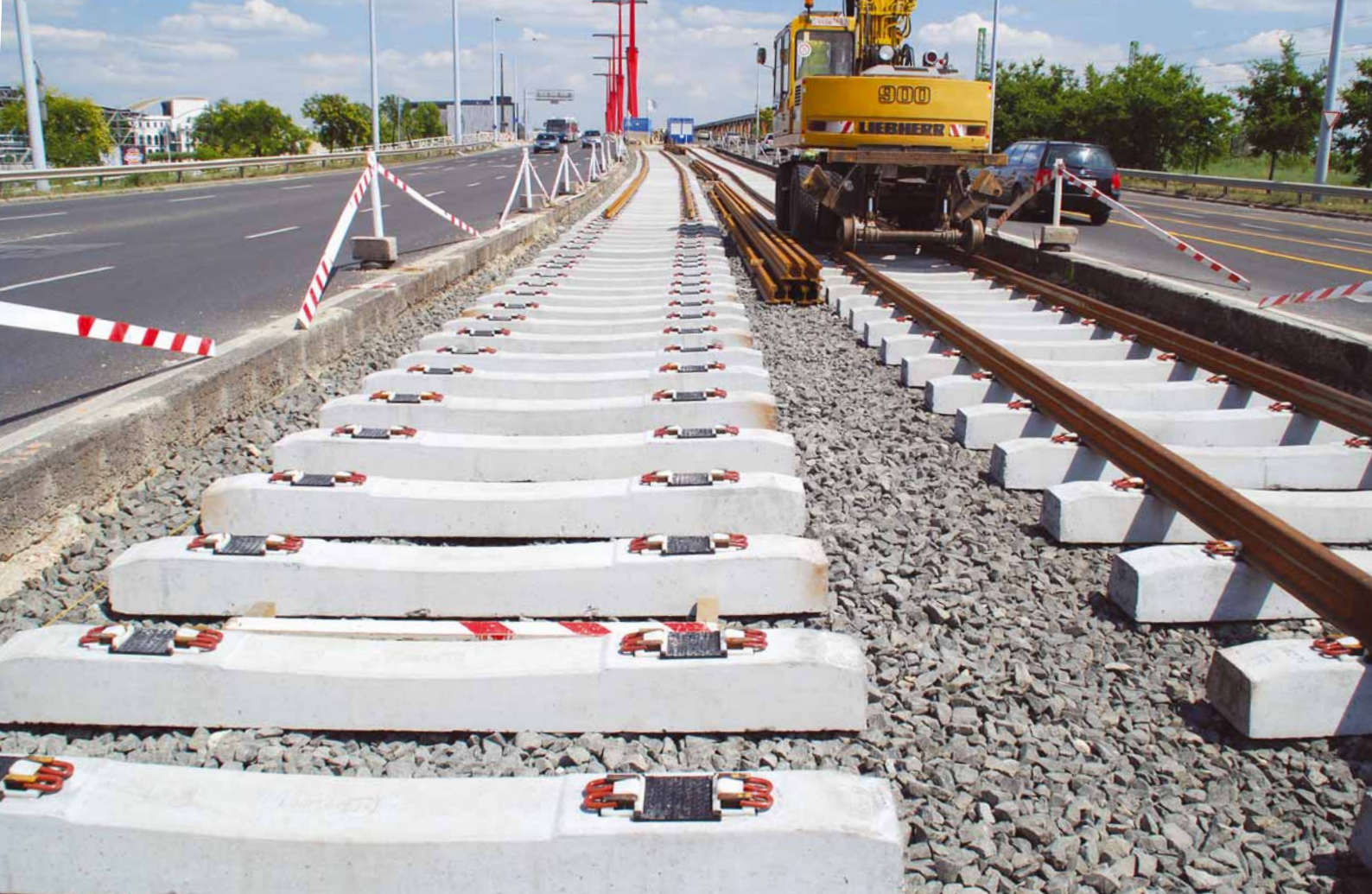
Zúzott köves szakasz Budán Pandrol leerősítéssel
