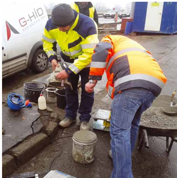
7. ábra: Levegőtartalom, konzisztencia és testsűrűség ellenőrzése beépítés előtt
