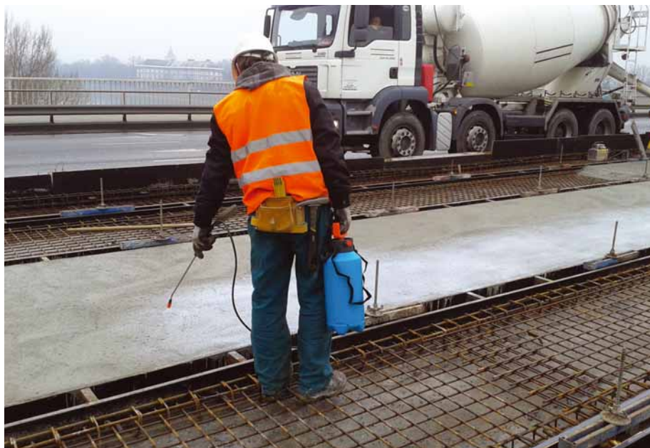
8. ábra: Beton utókezelése párazáró szer felhordással
