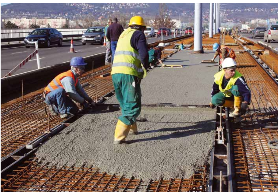
6. ábra: Pályalemez beton bedolgozása, lejtésképzés és simítás
