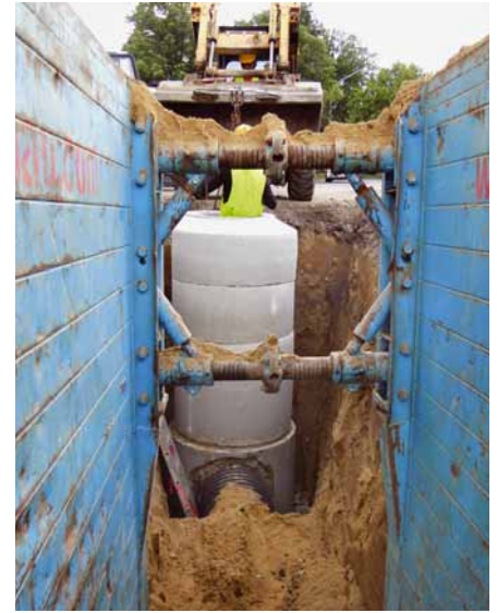
600-as csapadék csatorna
