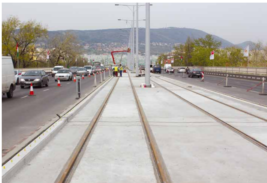
9. ábra: Az elkészült pályalemez és szegélyek a dilatáció környezetében
