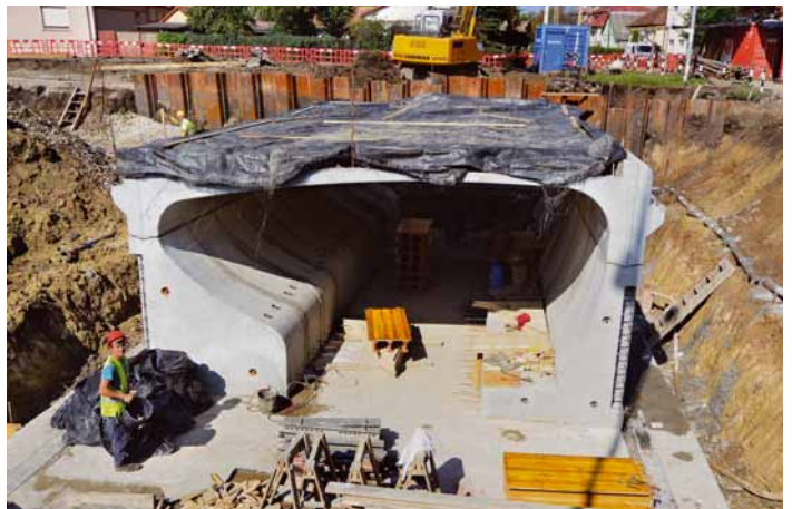
B3 műtárgy földkiemelése, talajvízszint süllyesztése
