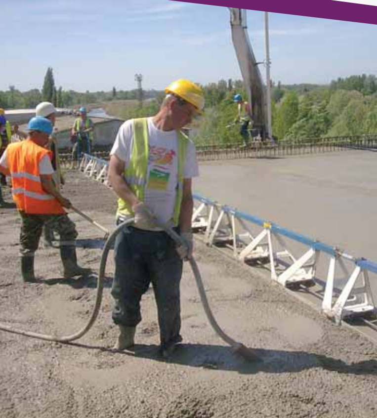
Bal parti ártéri híd pályalemez-betonzása
