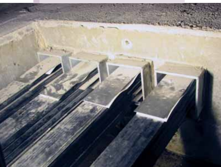
Befűzött, megfeszített VT-CMM kábelek
