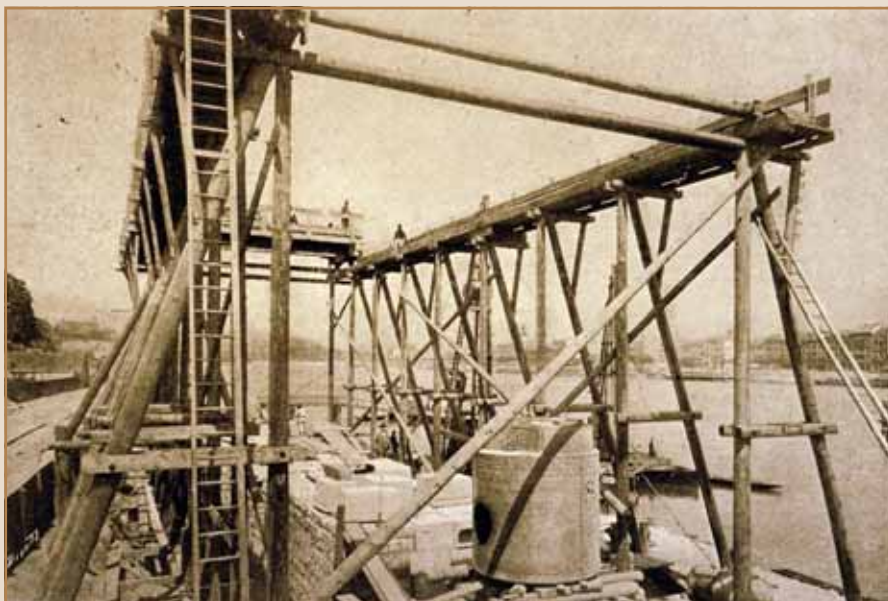
5. A Ferencz József (Szabadság) híd alépítményeinek alapozását süllyesztő-szekrények alatt építette a Gärtner és Zsigmondy cég. Képünkön a budai hídfő szerelőállványa és a keszon zsilipe látszik.
