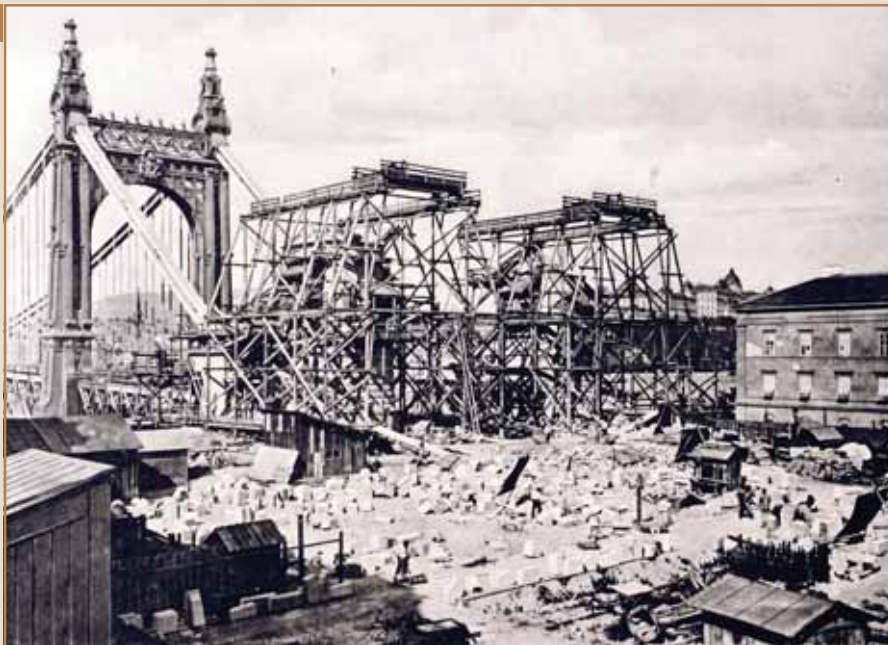
7. A Horthy Miklós (Petőfi) híd pesti süllyesztő-szekrénye és vasbeton hídfőjének szerelése;
