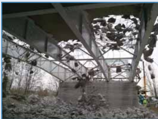
Az ártéri híd, bontás közben. Van benne betonvas...
