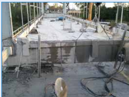
Ekkora darabokra vágtuk a keresztartót (~3 fm hosszú 2,5 tonna)
