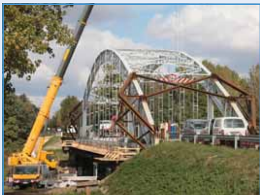
Az ártéri híd félig elbontva, a rákolló és vég-keresztartó rozsdásan és a bontott elemek
