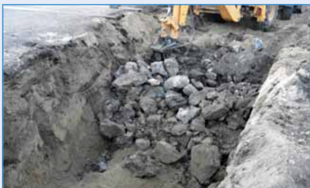
Meglévő áteresz bontása (Szerencs – Hidasnémeti)
