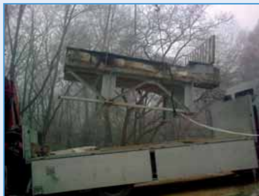
A kiskőrösi szakgyűjteménybe induló ártéri híddarab (aszfalttal, korláttal, dilatációval, sarugörgővel)
