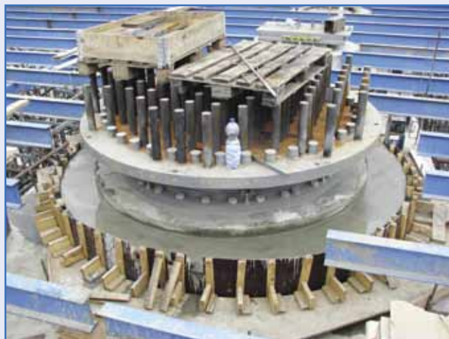
10. kép: 7. támasz beöntött KGE típusú egy irányban mozgó saru
