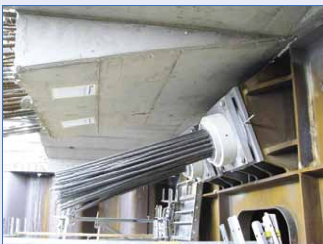
11. kép: Ferde kábel lehorgonyzás
