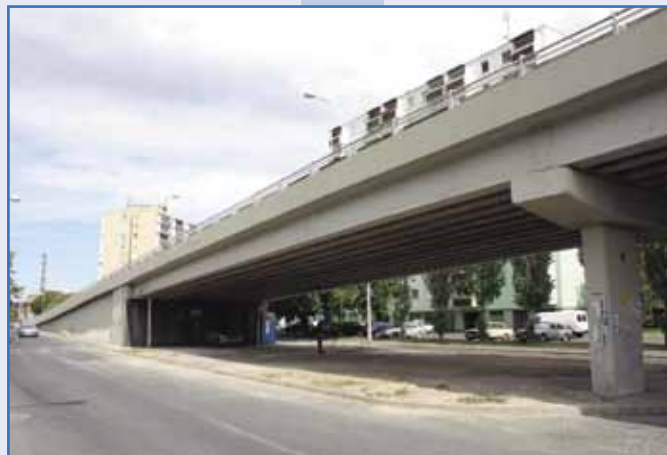
M3 ap. feletti Széchenyi úti felüljáró felújítása
