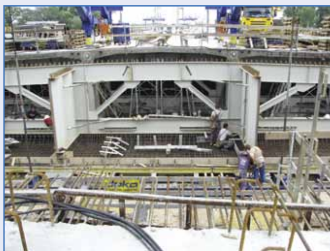
12. kép: Alsó lemez betonacél szerelése 2010. szeptember
