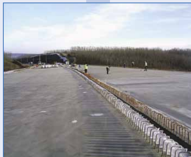
M31 ap. 64. jelű völgyhíd szigetelési, javítási munkái
