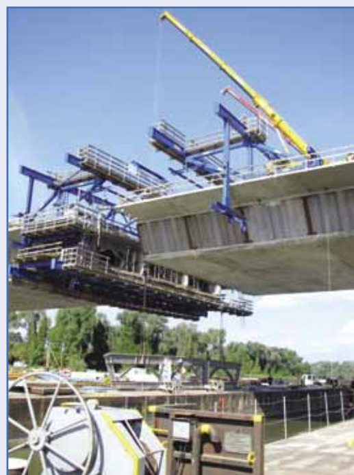
8. kép: Záró tag beemelése
