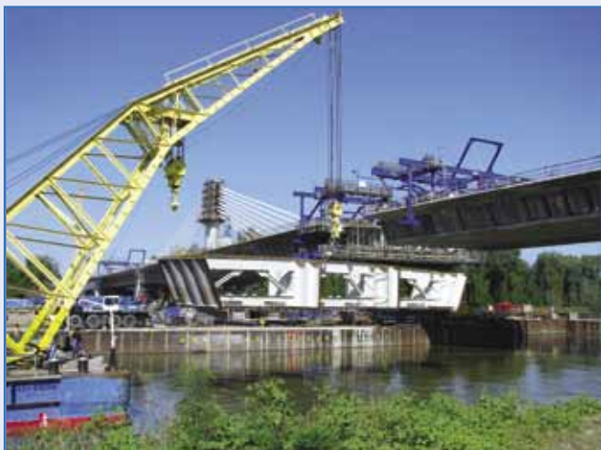
9. kép: Középső záró zöm beemelése (2010.09.23)
