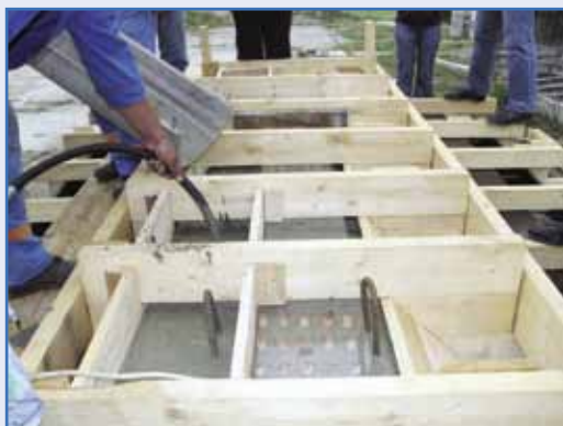
8. kép: Aszimmetrikus próbaszalu betonozó sávval
