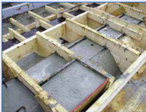
7. kép: Szimmetrikus próbaszalu betonozó nyílással
