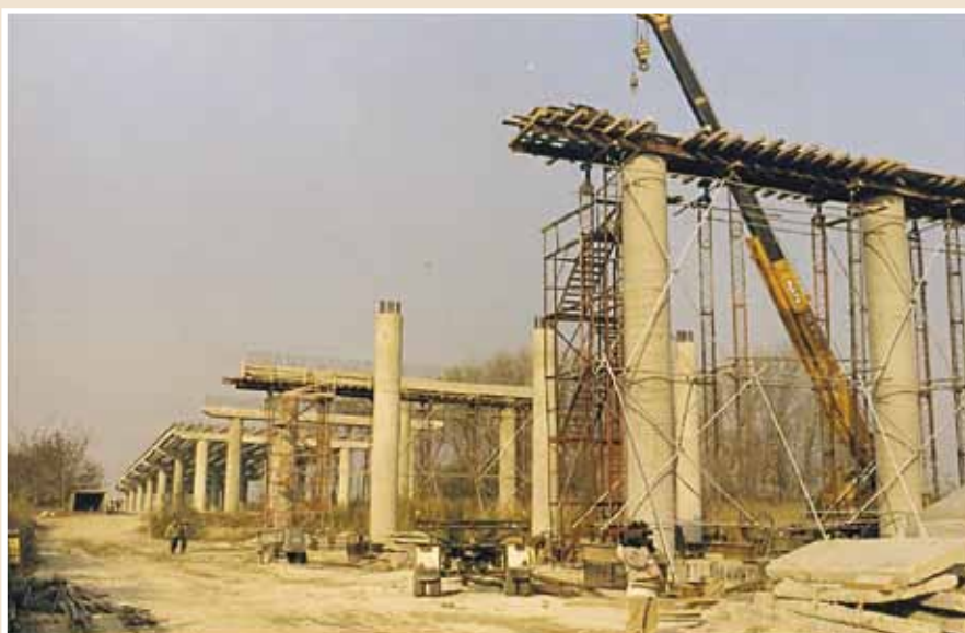
5. kép: Oszlopcölöpként kialakított támaszok a feljáróhídnál
