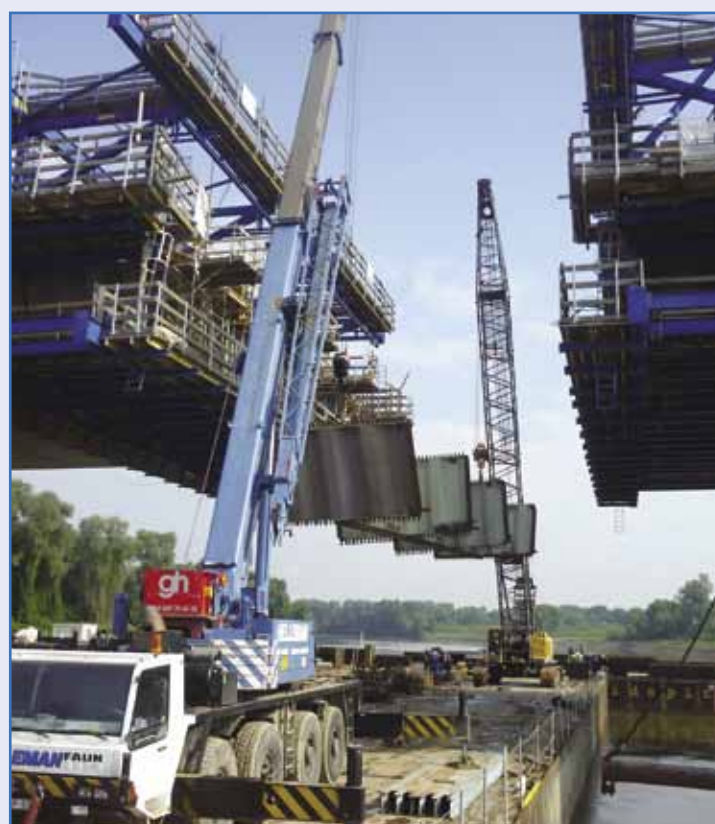
7. kép: Emelések két daruval
