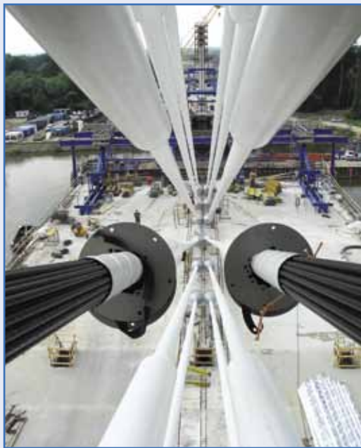
4. kép: Feszítőpázmából alkotott kábel
