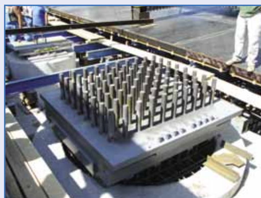
2. kép: 6. támasz KF típusú fix saru
