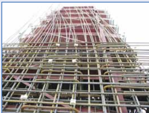
6. kép: Kábelek csúsztatónyeregben
