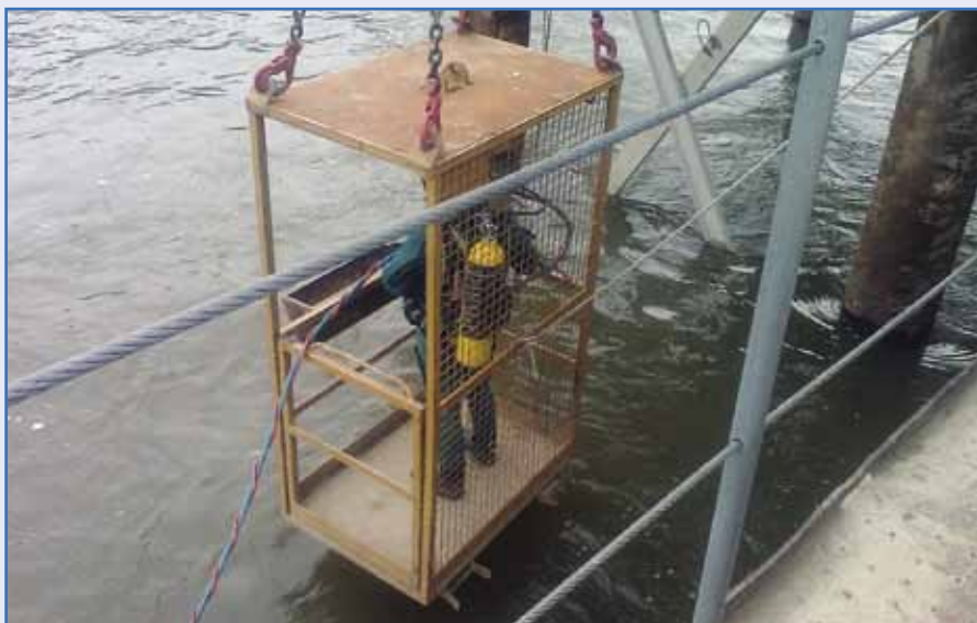
Búvármunka a szorítóbilincsek felszereléséhez
