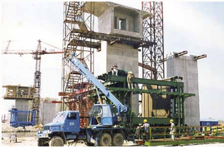
3. kép: Párba szerelt zsaluzókocsi felszerelése a rövid indítózömrre
