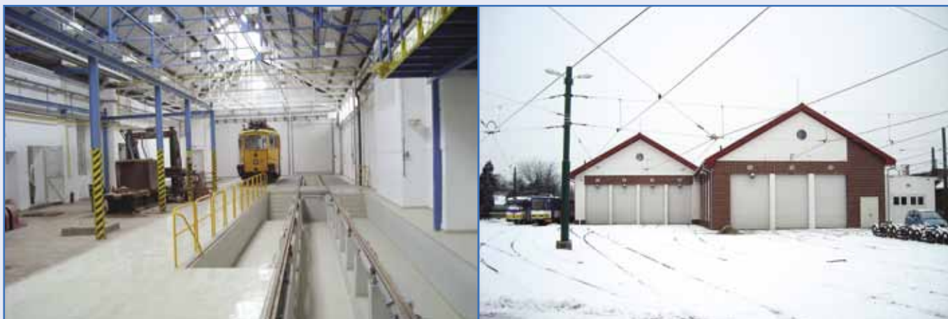
Szeged, Pulz utcai villamos remiz felújítása
