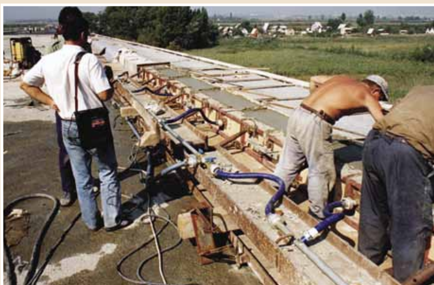
2. kép: Vákuumtechnológiával épülő hídszegély
