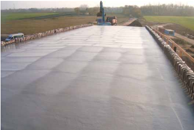
„445 sz. Kecskemét elkerülő út 5 sz. és 44 sz. főút közötti szakasz építése” projekt - 6. sz. híd szigetelése
