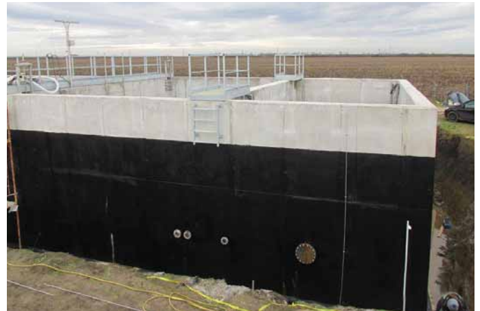
„Emődi szennyvíztisztító telep technológiai fejlesztése” elnevezésű projekt keretében - szennyvíztisztító telep, szennyvíz-csatorna, üzemirányító rendszer, szagtalanító rendszer és meglévő regionális szennyvízátelők rekonstrukciójának tervezése és kivitelezése
