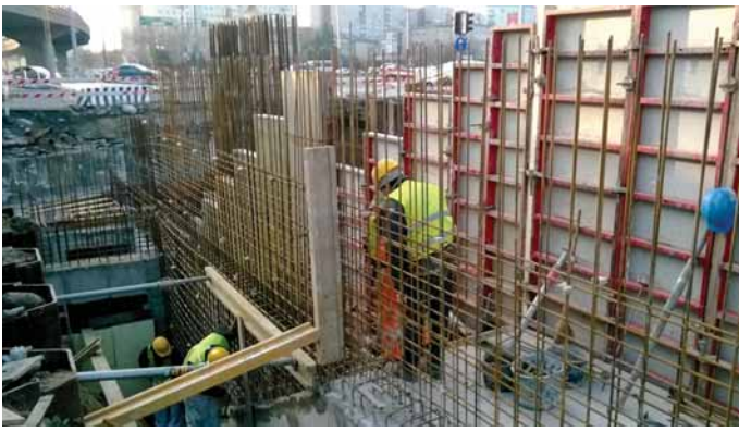
Budapest 1-es villamos vonalának komplex felújítása - Flórián tér megálló gyalogos aluljáró szerkezetépítési munkái
