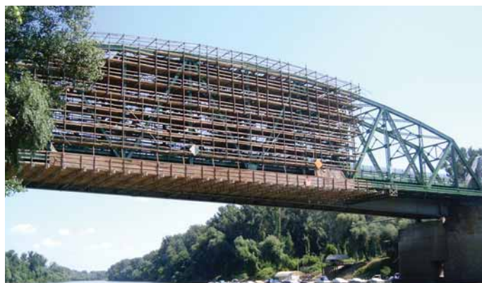
Kecskemét Kunszentmárton vasútvonal 302+41 szelvényben lévő Tisza-bridge mázolósa
