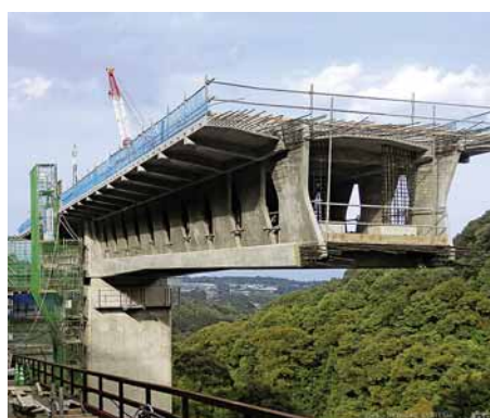
A híd építés közben
