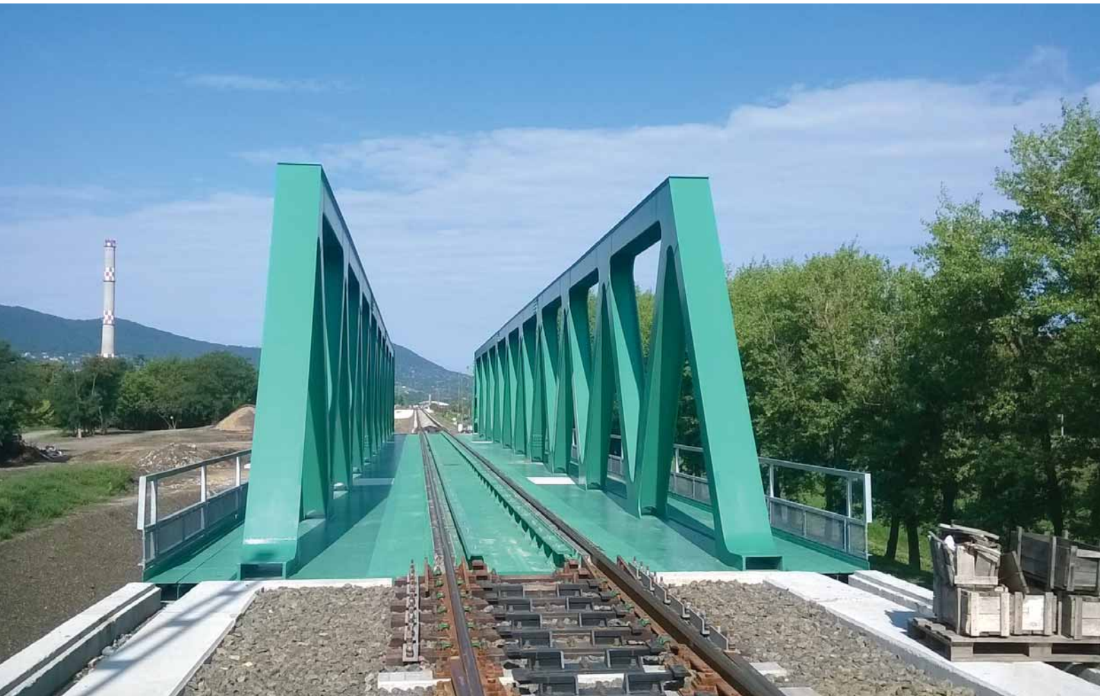
„Északi Vasúti Duna-híd - Pilisvörösvár vonalszakasz pálya és műtárgyépítési, valamint kapcsolódó ideiglenes biztosítóberendezési, távközlési, közmű-kiváltási, kábelkiváltási munkák tervezése és megvalósítása” tárgyú projekt keretében - Jégtörő utcai vasúti híd komplex építése
