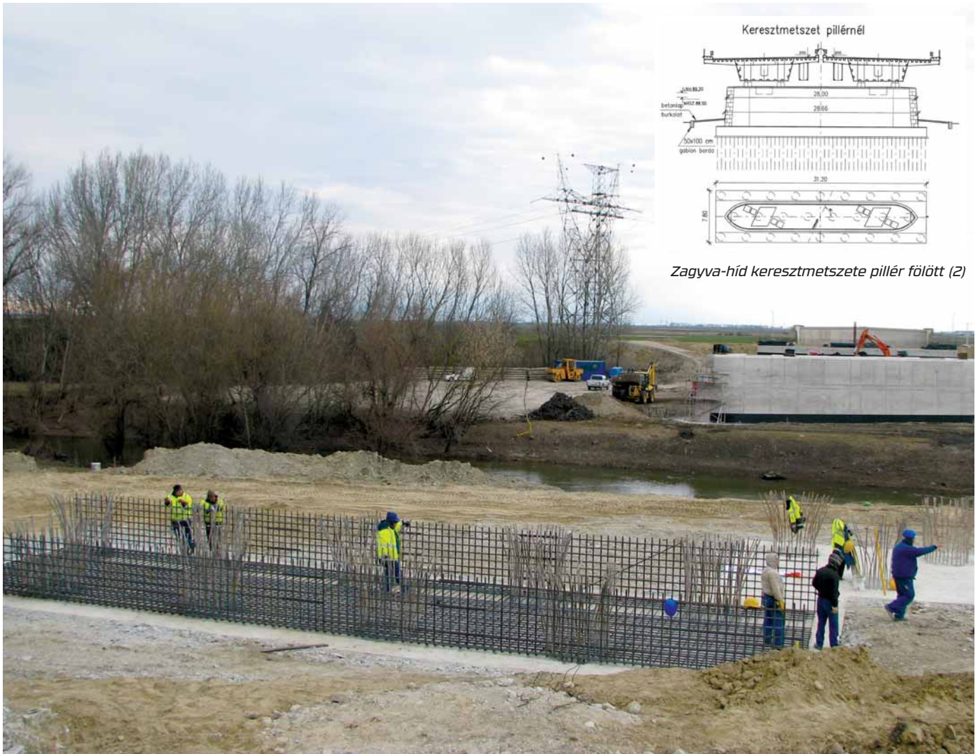
Zagyva híd - 1-es hídfő vasszerelés (3)
