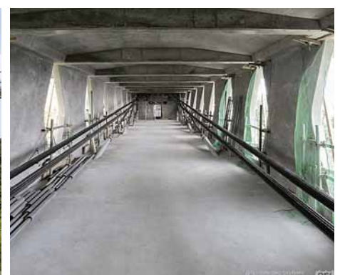
A híd belülről
