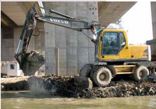
A Larssen lemezek kihúzását követően a műsziget és a Larssen lemezek visszahorgonyzását szolgáló vb. gerenda bontása is megkezdődött
