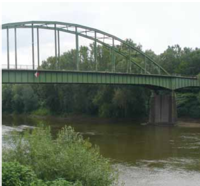
1. A meglévő híd
