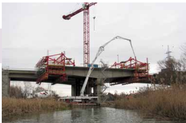
14. jelű mérlegág - 3. zömpár mederoldali II. ütem betonozása
