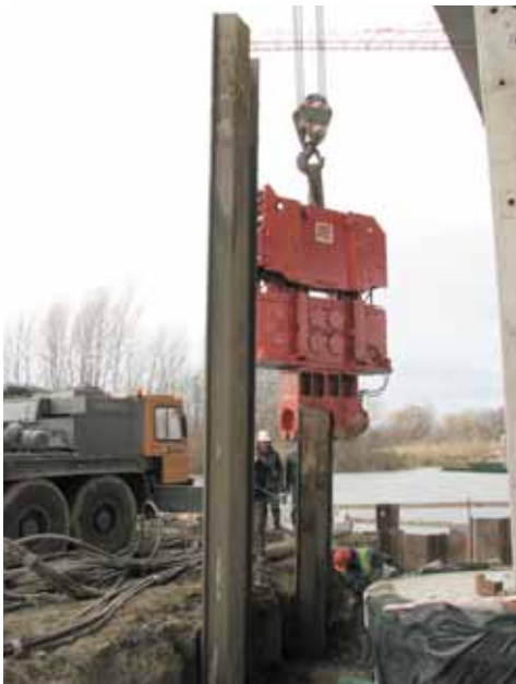
15. jelű támasz – befejeződtek a munkák a műszigeten, megkezdődött a visszabontás tízméteres Larssen lemezek húzásával
