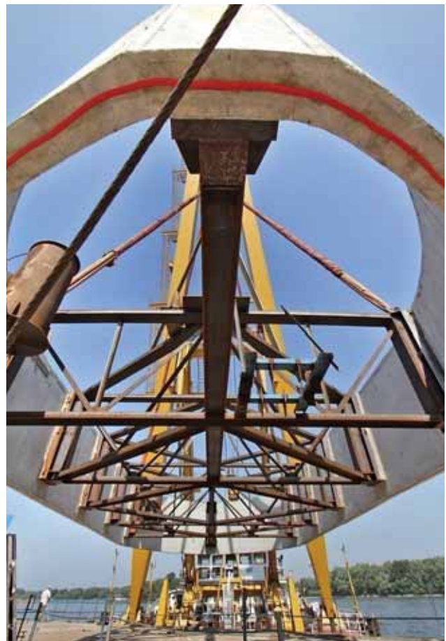
Hárosi Duna-híd mederpillér
