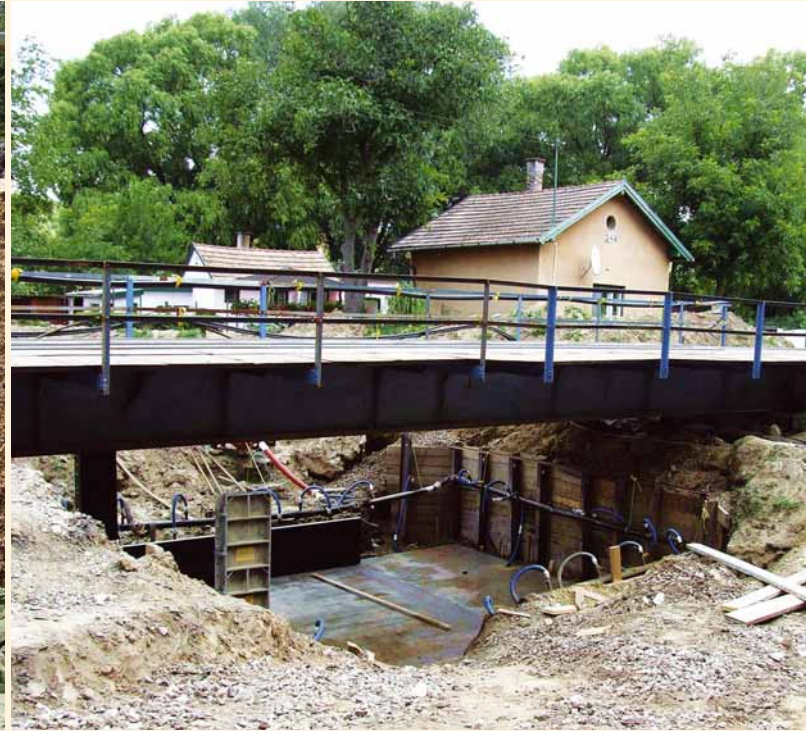
Műtárgy építés provizórium védelmében
