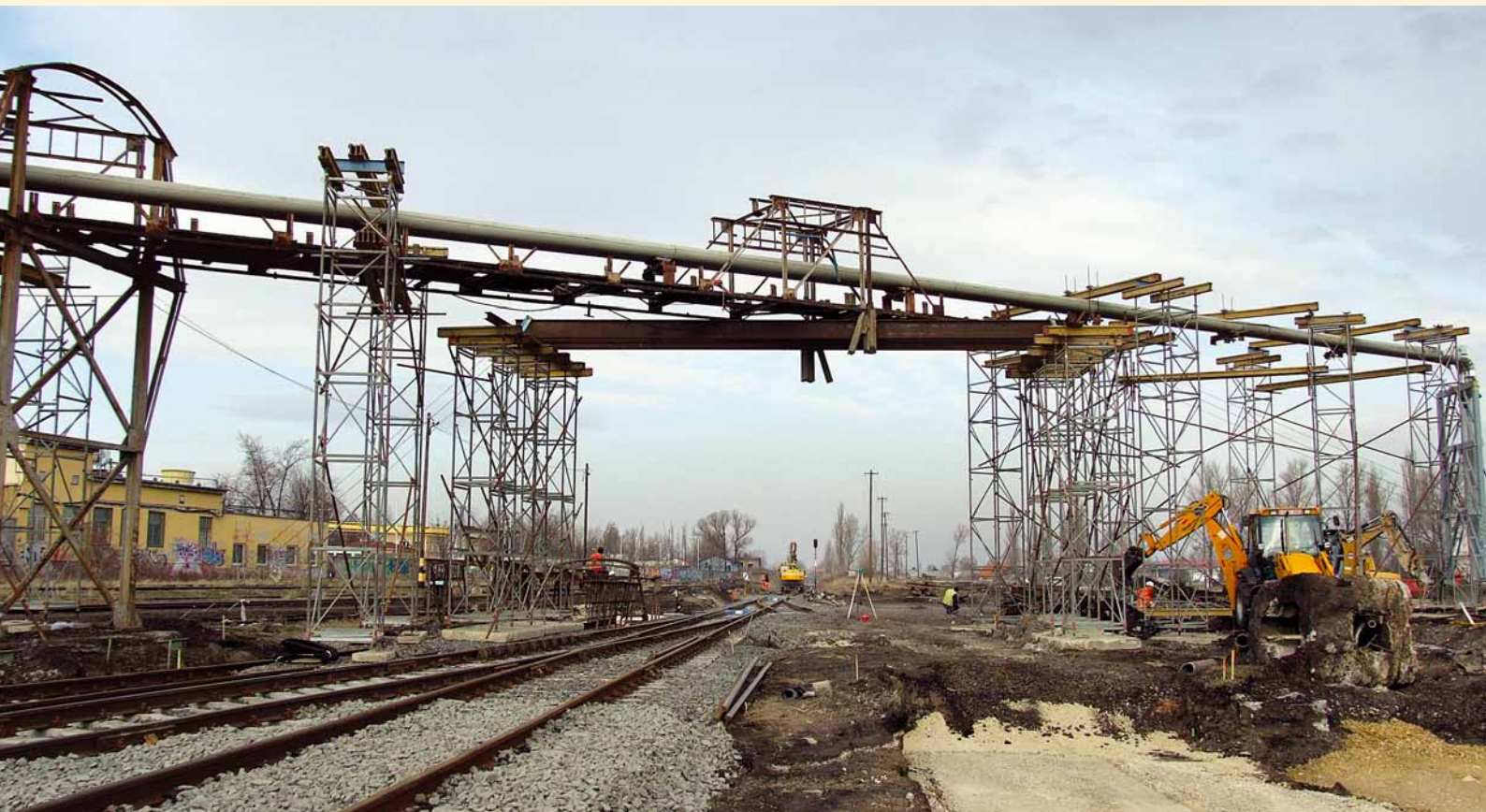
A csóvédő híd ideiglenes megtámasztása bontási fázis után
