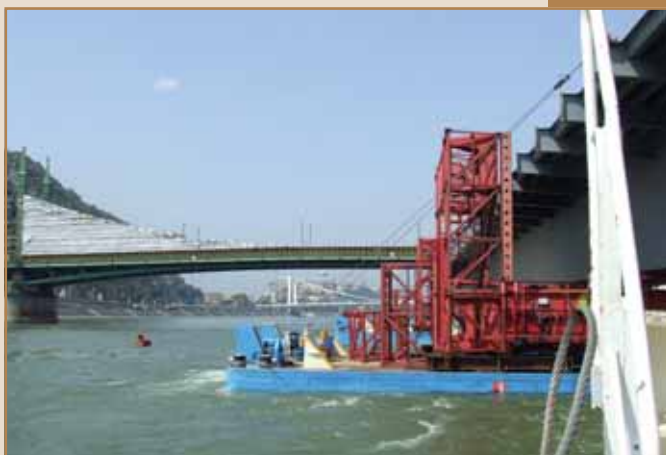
A Megyeri híd egyik elemének szállítása Csepelről, bárkákon
