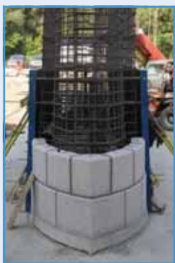
Ártéri pillér kőburkolattal, zsaluzattal, betonozásra várva
