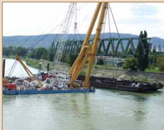
Az Újpesti vasúti híd átépítése: egyik szerkezeti elem emelése
