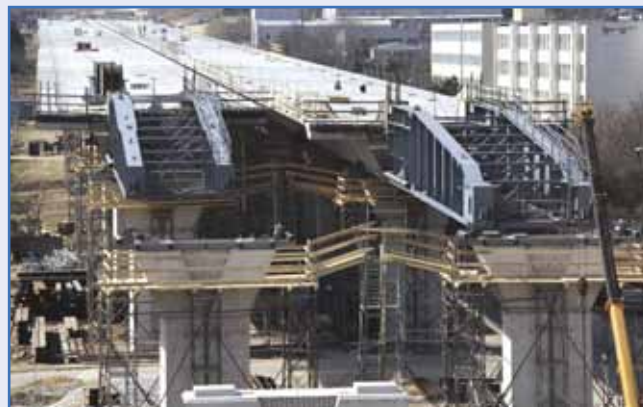
Csőr az utolsó előtti pilléren, mögötte 700 m kész szerkezet
