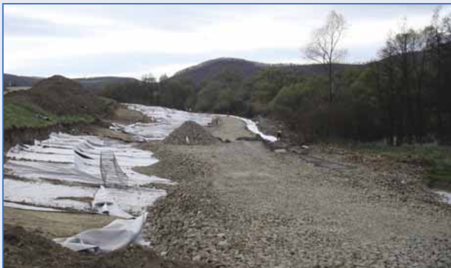
Épül a magyar oldali út is
