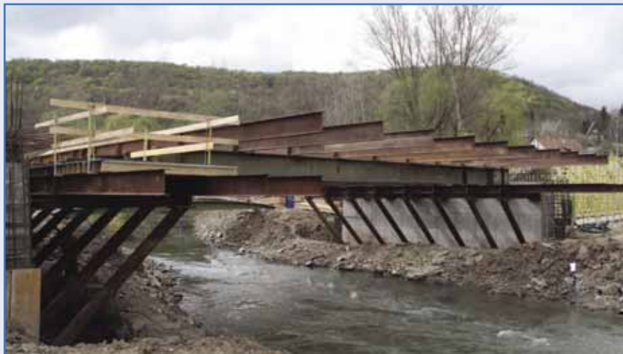
Medernylás felett az ideiglenes acélszerkezet
