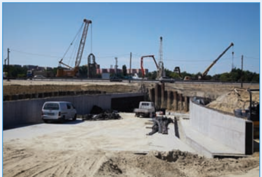
A Növény utcai aluljáró építése
