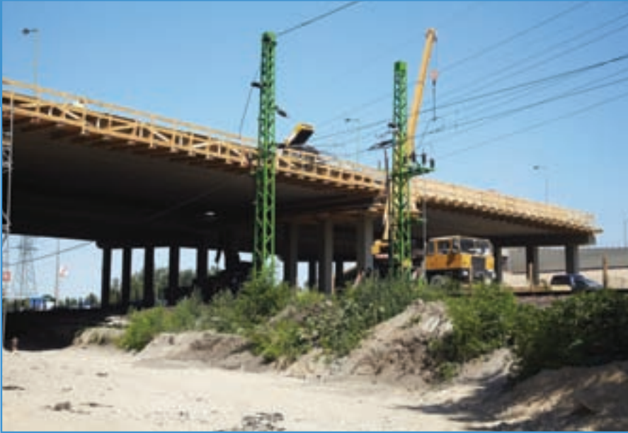
A 3.08 jelű híd építése
