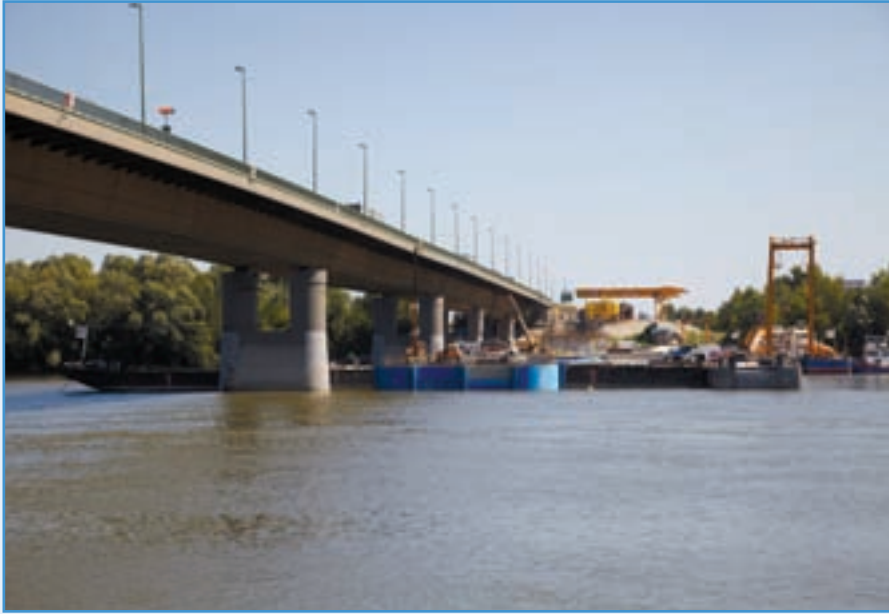
Hárosi Duna-híd mederpillér építése
