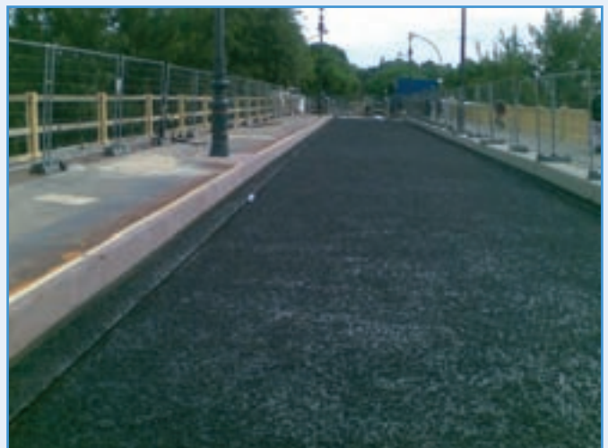
Az elkészült szigetelést védő aszfalt
