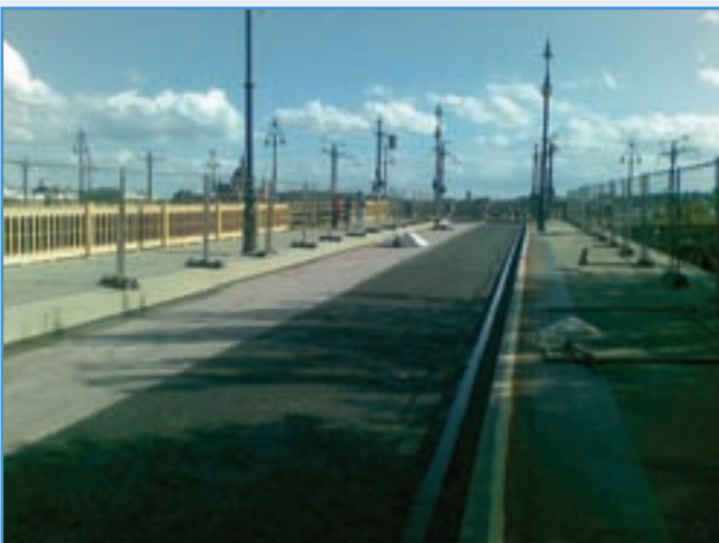
A szigetelés kezdete
