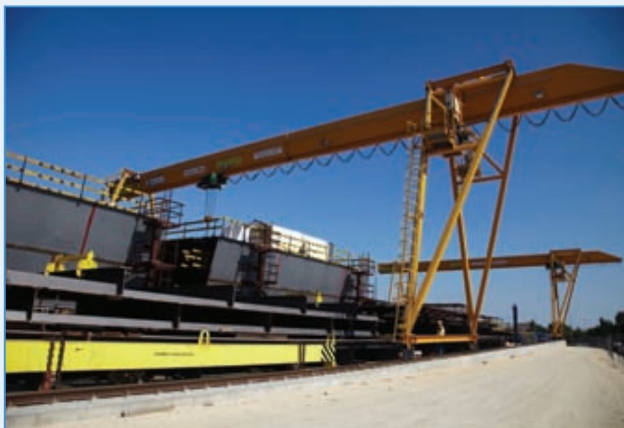
Hárosi Duna-híd bal parti szerelőrete elsőelemek
