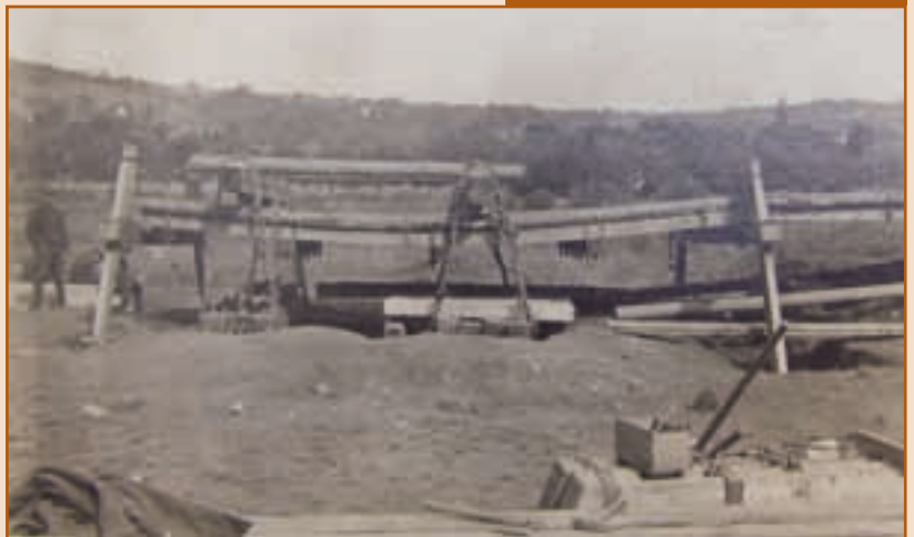
Folytatólagos, többtámaszú fagerenda-vendég-híd teherbírási-alkalváltatói kísérlete, 1930 körül
