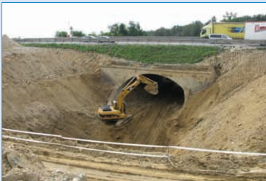
1. 2.02/2 jelű műtárgy Tubosider munkagödre és a meglevő szerkezet befolyási oldala
