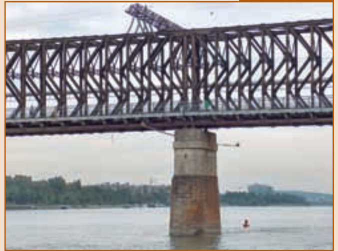
Az Északi vasúti híd 2008-ban elbontott szerkezete
