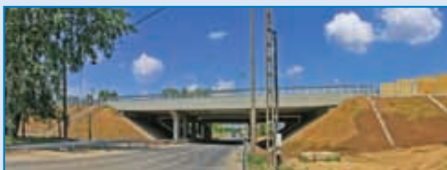
Hídszélesítés zajvédő fallal
