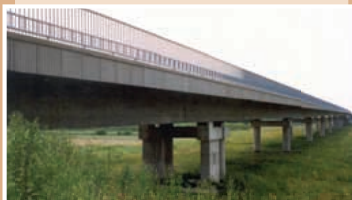
Szolnoki „Százlábú” ártéri híd
