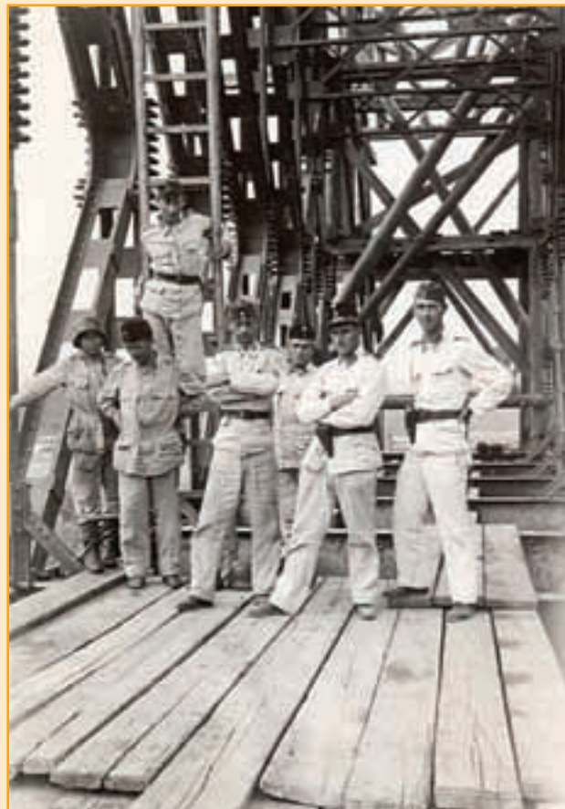
8. kép K híd próbaszerelése, 1929
