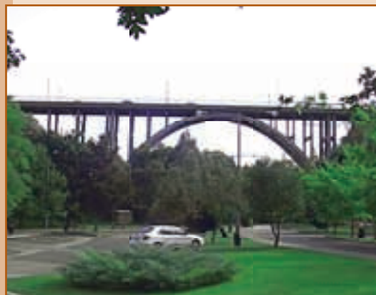
Veszprém, Szent István völgyhíd. A monolit vasbeton völgyhíd 1936 és 1937 között épült. Szilárdulási folyamatát a téli időben – első ízben itt – gőzöléssel biztosították.
