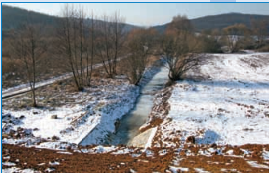
Dónai záportározó vízoldala
