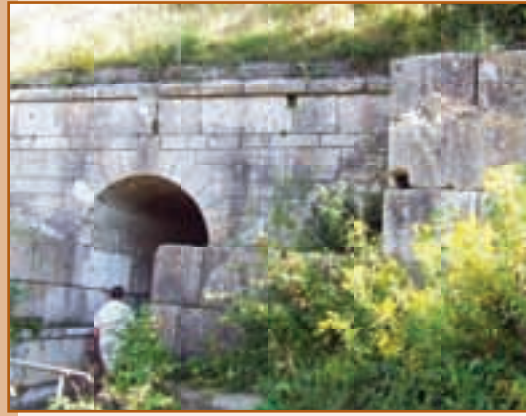
Kikeri gát. A töltés egy szakaszán boltozaton halad át. Itt vezet át az a patak, melyet e gáttal már a rómaiak elzártak és a pátkaihoz hasonló mesterséges tavat hoztak létre. A gát mai, külső falazata későbbi építmény, a római a töltés magjában áll.
