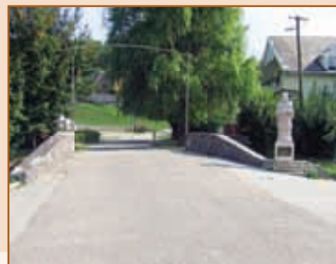
Bajót, híd. A feltehetően törökkori építésű híd álló félkör boltozatú. Nyílása 1 1/4°, szárnyfalai ferdék. Hídfőjén Nepomuki Szt. János szobra áll. A közelmúltban (ismeretlen időpontban) szerkezetét felújították: felületét kőlemezekkel burkolták.
