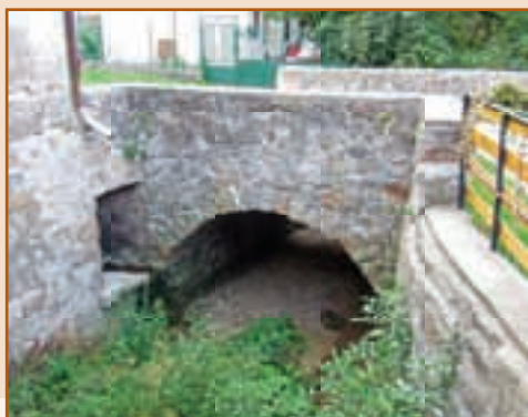
Pilisborosjenő, boltozott kőhid, tört alaprajzú szárnyfalakkal. Nyílásmérete 2°, a település háza szorosan közrefogják, a növényzet erősen benőtt. Korábbi megfigyelések szerint – a fotó készítése idején is – többnyire száraz a patakmeder.
