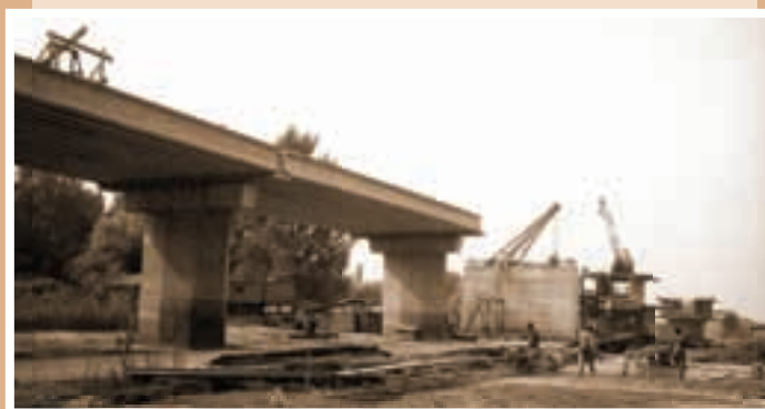
Szentes-csongrádi híd, parti szakasz, előgyártott elemekből
