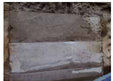
Partfal külső felülte helyreállított állapotban
