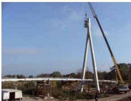
Hatvani gyalogos híd acélszerkezeti munkái valamint a "ferde kábelek" kiépítése és egyéb hídmozgatási munkák
