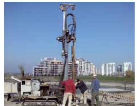
Betonozási furat elkészítése a térbeton felől
