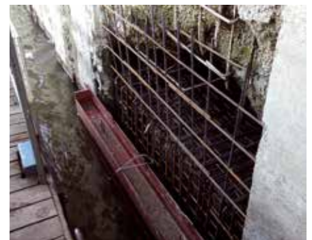
Betonacélok beszerelve a víz alatti betonozás előtt
