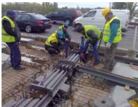
Dilatáció beépítése az Árpád hídon
