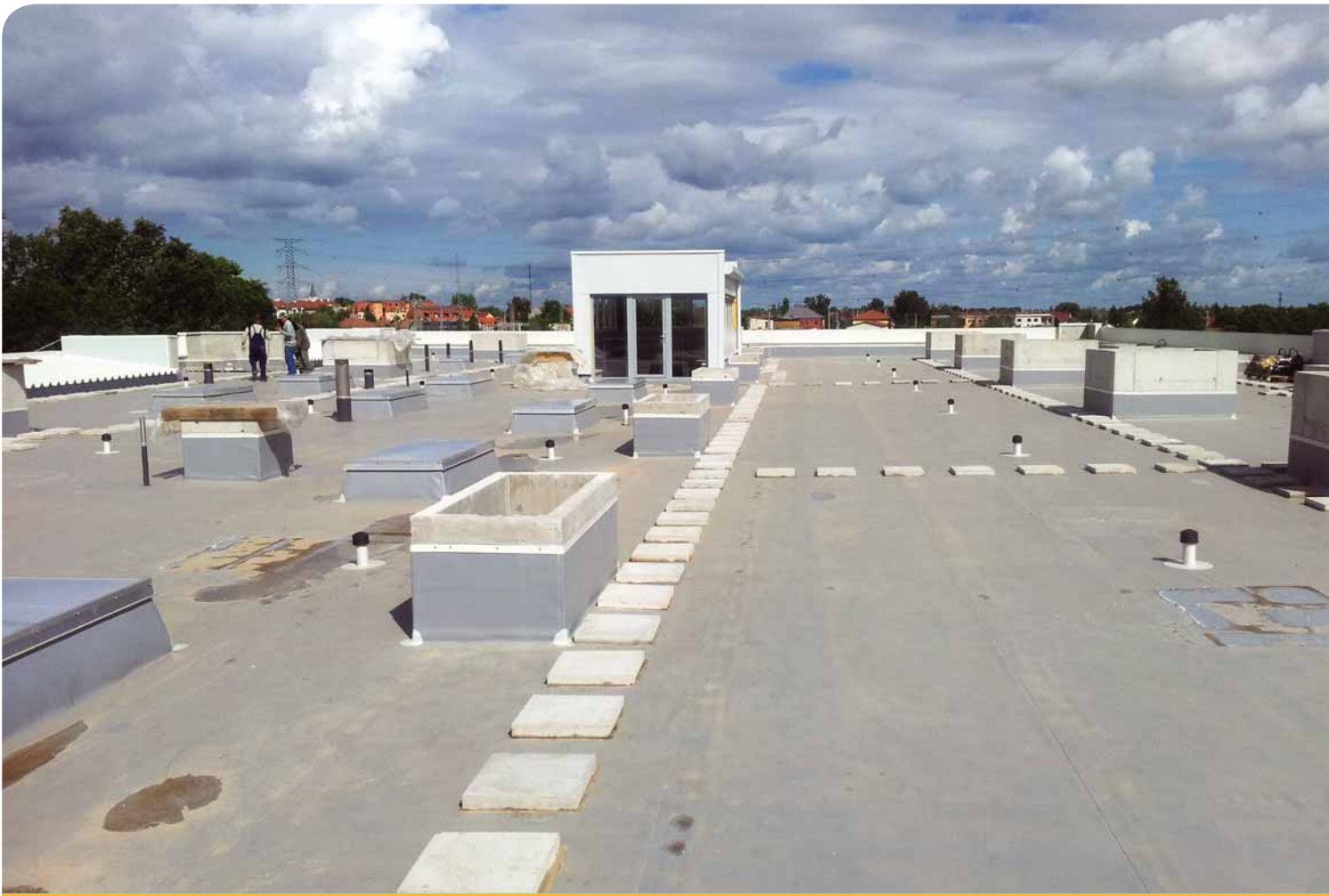
Mórahalom szennyvíztisztító telep tetőszigetelése...
