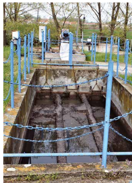
Régi szennyvíztelep oxidációs árkok és előmechanika (dobrács)
