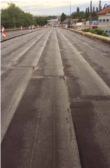
Pécs Árpád-híd felújítása
