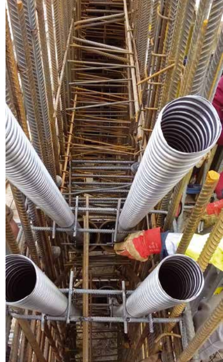
3. Burkolócsövek a betonacél-armatúrában
