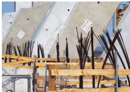
4. Feszítésre váró befűzött pászmakótegek fölfelé kiálló végei
