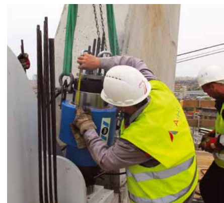
6. Ellenőrző mérés a feszítősajton
