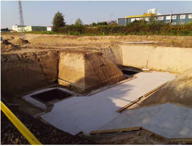
11. Peronaluljáró liftaknákkal, szerelőbetonnal
