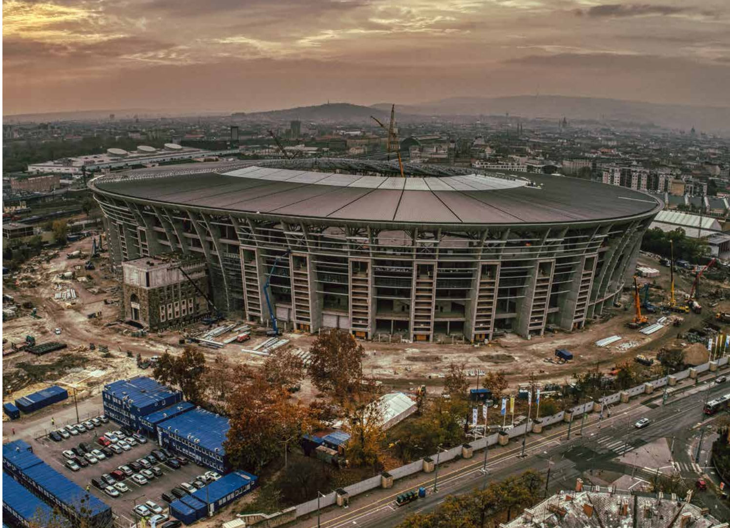
9. Az Új Puskás Ferenc Stadion építésének állása 2018 novemberében
