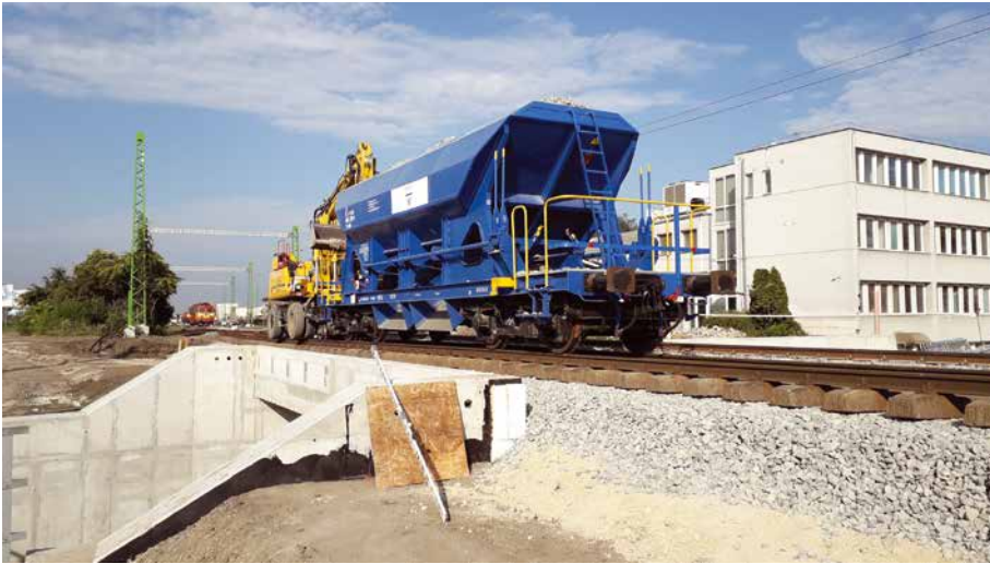
3. Vágóhid utca felüljáró komplett felszerkezete
