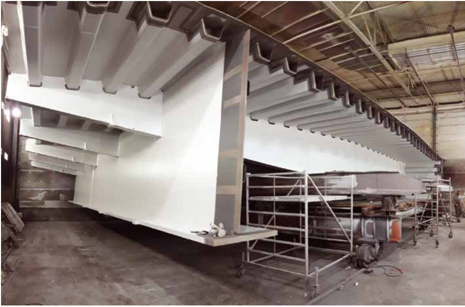
Komárom, Duna-híd üzemi korrózióvédelme
