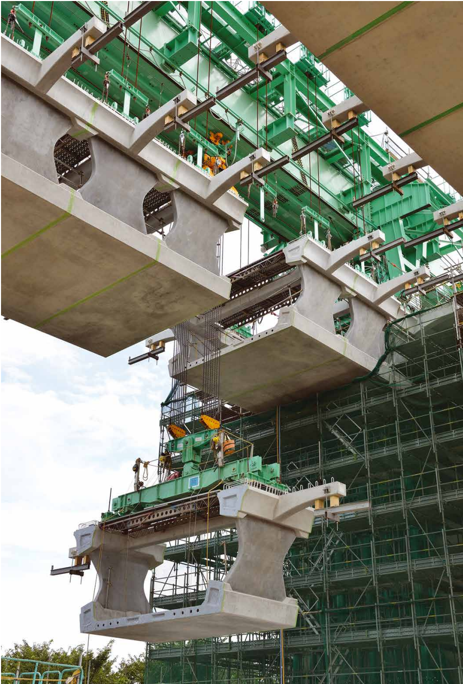
7. Okegawa-viadukt építése részbeni helyszíni előregyártással
