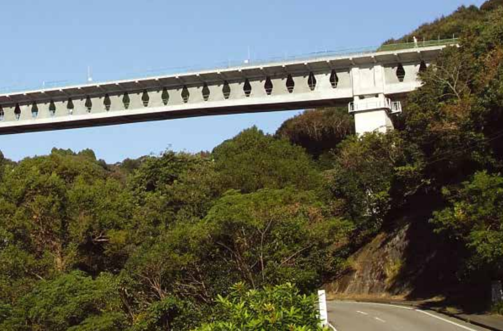
1. Pillangóbordás híd építés közben
