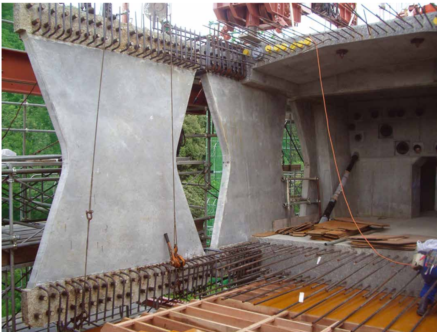
6. Takubogawa-híd építése szabadbetonozással: Pillangó bordaelem a zsaluzatban
