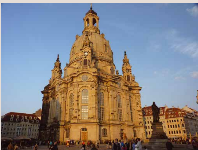
Drezda, Frauenkirche újjáépítve
