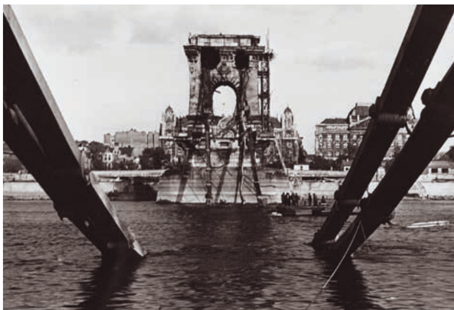
A lerombolt Lánchíd (Közlekedési Múzeum fotótára)
