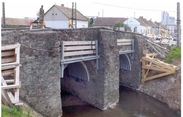
Bonyhád - a kétnyílású, boltozott híd javítás alatt, Nepomuki Szent János szobrával
