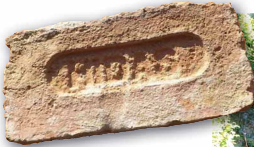
Tégla az Erdei patak részben leomlott burkoló falazatából;
