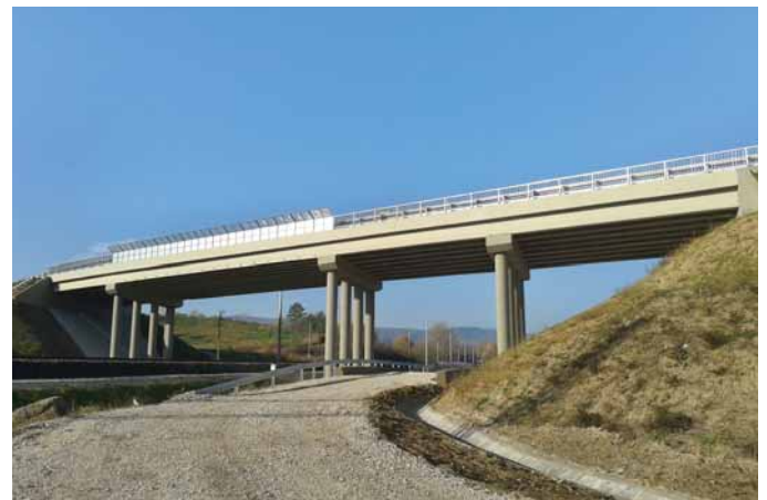
8. kép: A 11106 j. út felüljárója Solymáron
