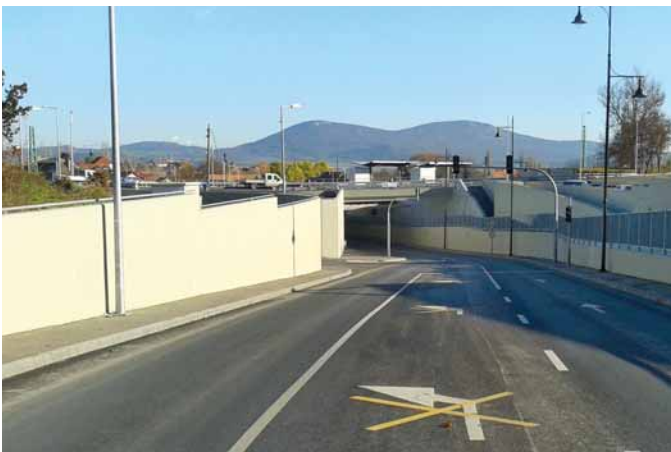
7. kép: A 10. sz. főút aluljárója Pilisvörösváron
