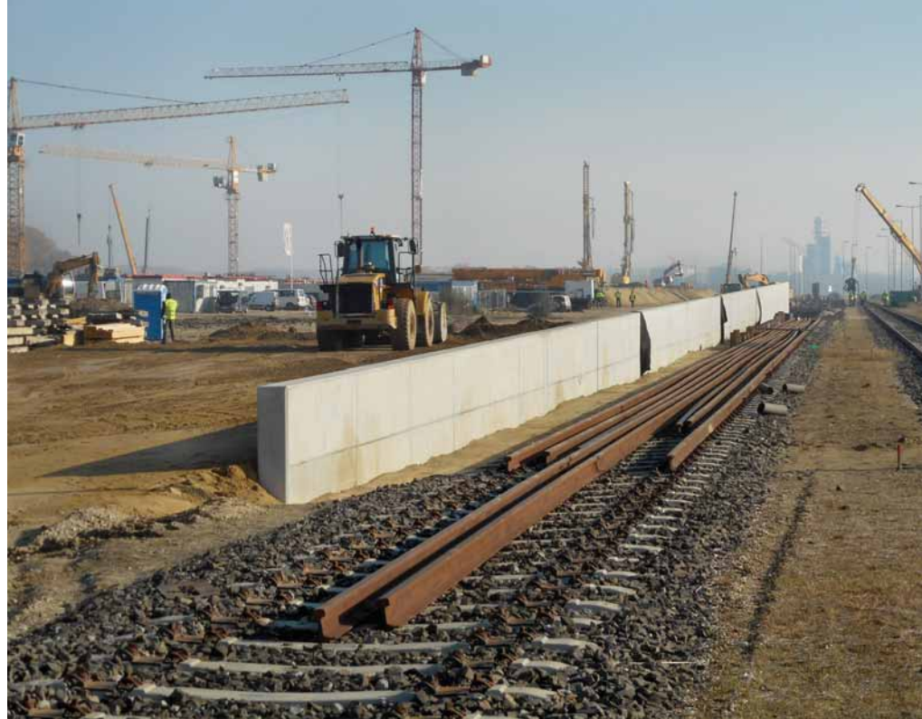
Elkészült vasbeton szögtámfal az iparvágány mellett
