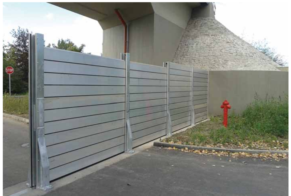
12. kép: A Nánási úti felüljáró alatti mobil gát próbaszerelése
