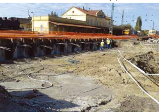
Száfal horgonykésítéssel és az Állomás jelenlegi épülettel a háttérben
