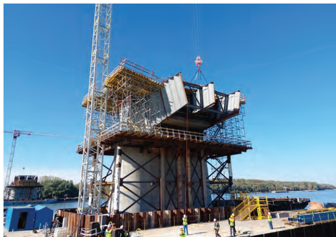
6. kép: Az első azaz 02-es acélszegmens felakasztva, ami zsaluzókocsival épül
