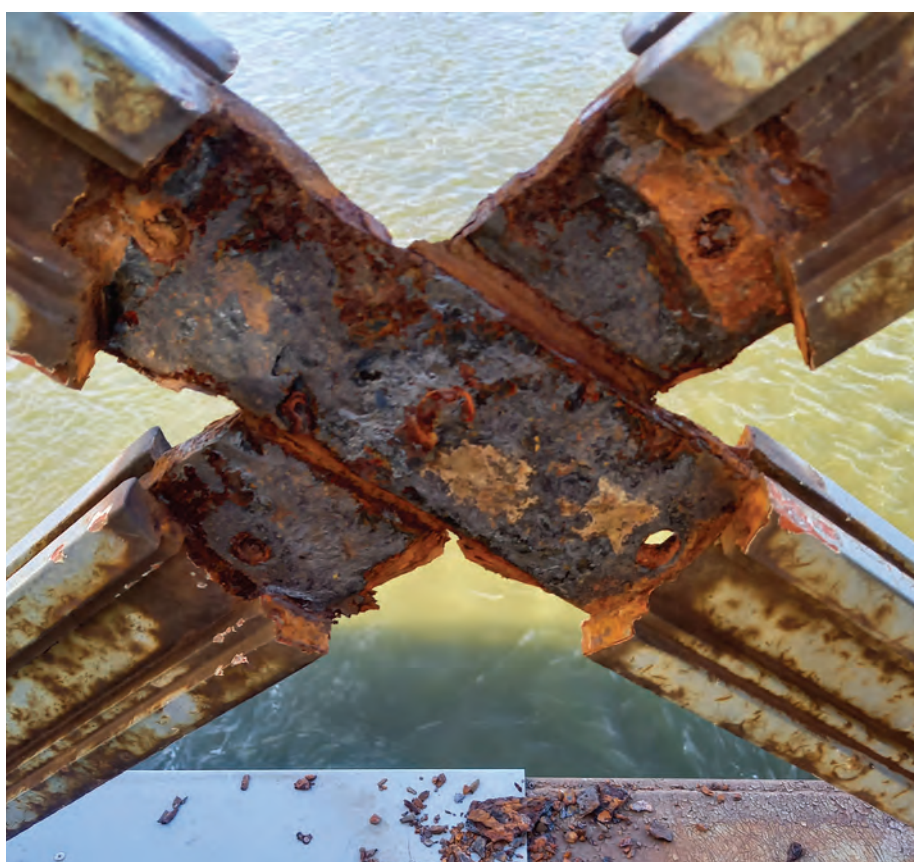
4. kép: Oszlopok törései és korróziós károk (Fotó: Tímár Lőrinc)
