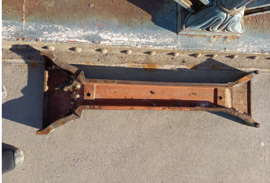
3. kép: Hídkorlát dilatáció szerkezet (Fotó: a szerző felvétele)
