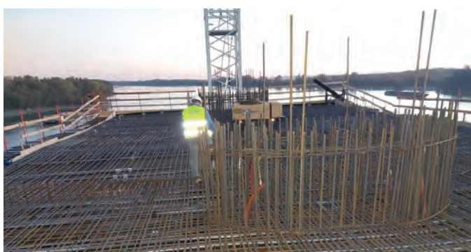
4. kép: Indítózöm pályalemez 69 kábelburkoló csővel betonozásra várva
