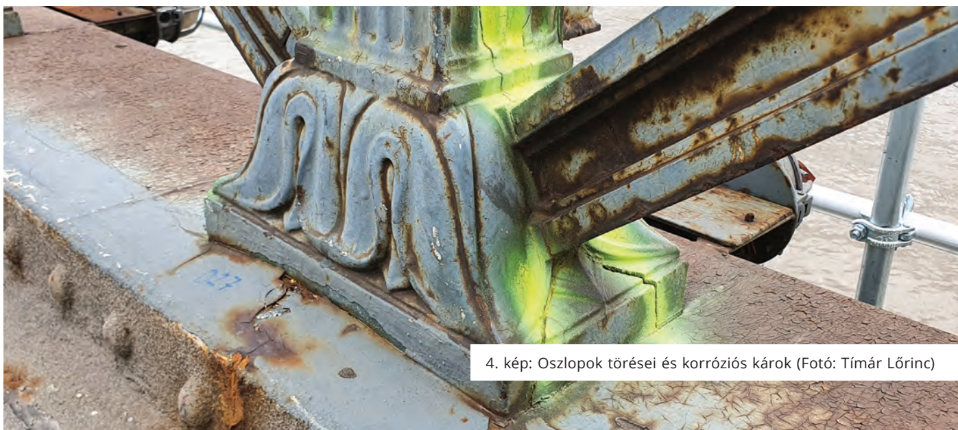
4. kép: Oszlopok törései és korróziós károk (Fotó: Tímár Lőrinc)
