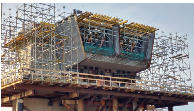
3. kép: Indítózöm fenéklemez és falazat kész, pályalemez fenékszaluzata készül
