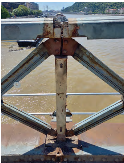
3. kép: Hídkorlát dilatáció szerkezet (Fotó: a szerző felvétele)
