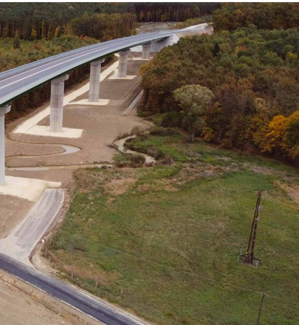
Vasszentmihályi völgyhídon alkalmazott félig előregyártott H hídszegély
