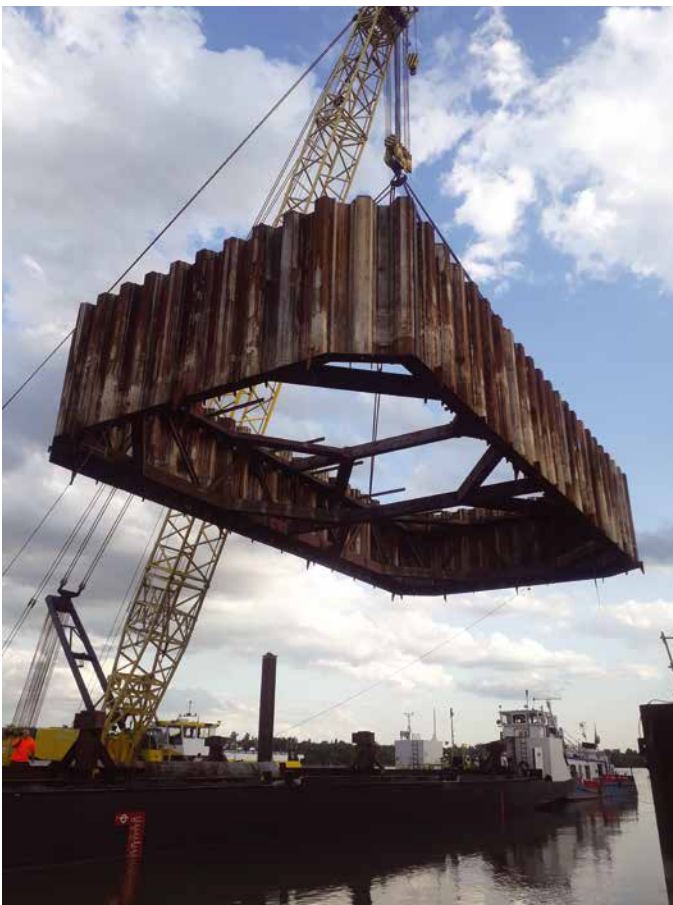
Őrfal emelése gyártótérről a bárkára
