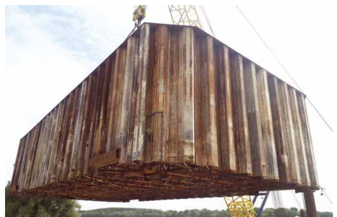
Kéregelem emelése a gyártótéren
