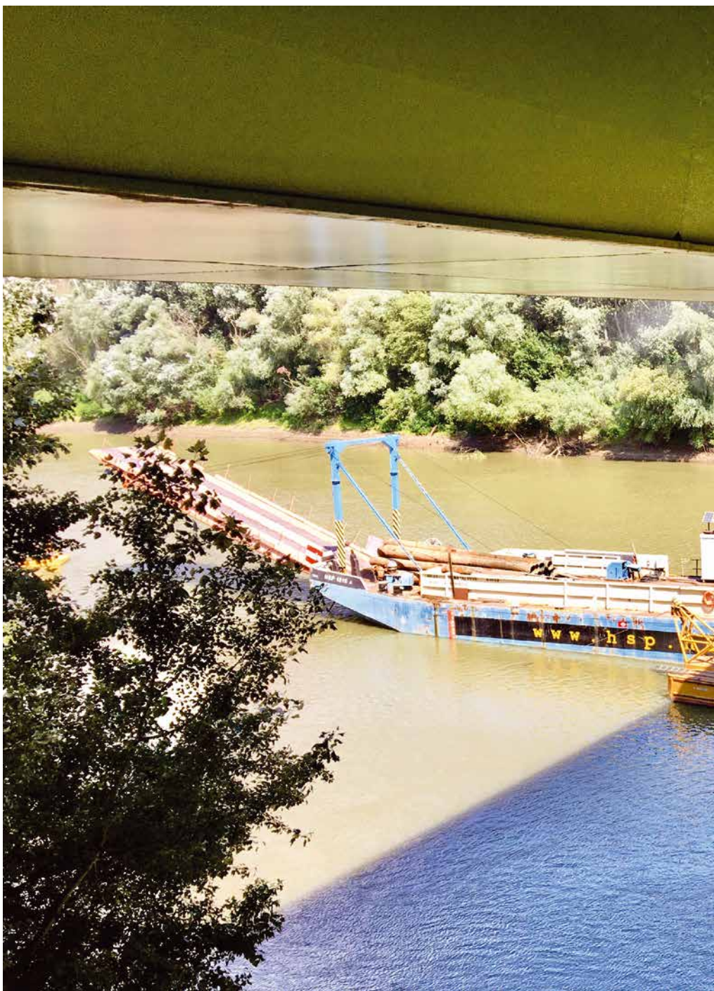
Balpálya szerelőcsőr második tagjának előkészítése emelésre
