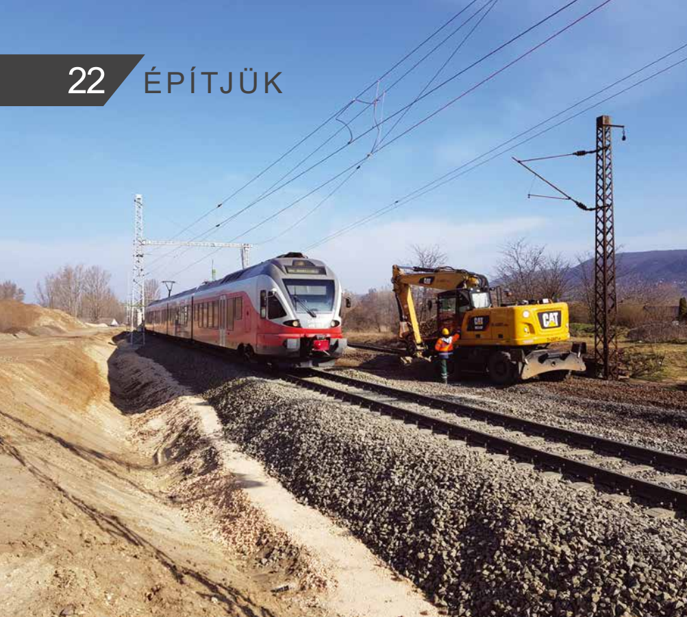
5. kép: A jobb oldali terelővágányon már zajlik a vasúti forgalom, a bal oldali vágányon folyamatban van a hétévi, 54 órás vágányzár keretein belül történő csatlakoztatás és forgalomba helyezés (fotó: Szabó Imre A-Híd Zrt.)
