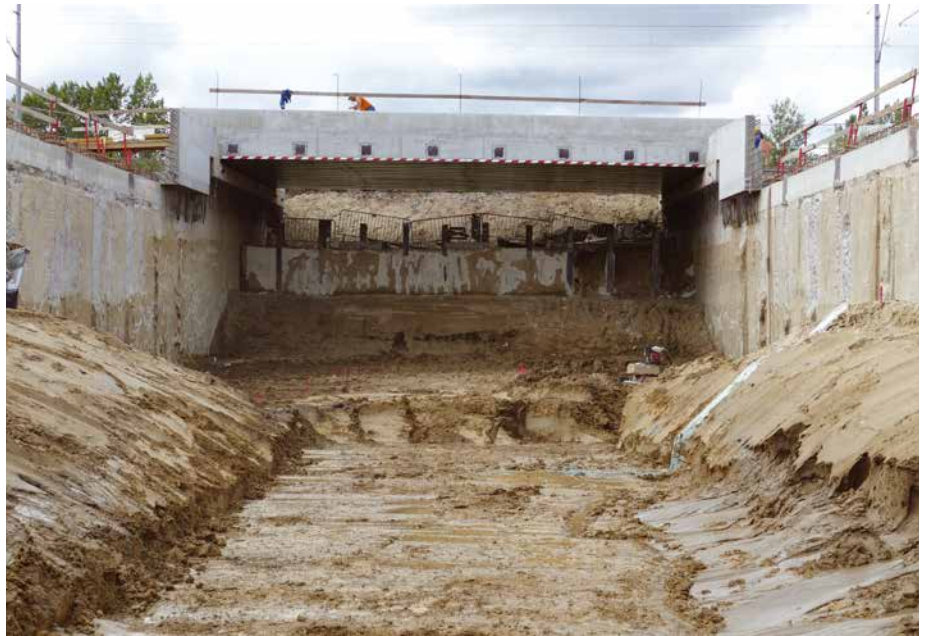
7. kép: A vasúti híd kész szerkezete, alatta a terelővágány állékonyságát biztosító zagyfal, oldalt az aluljárót határoló két vasbeton résfal (fotó: Varga Zoltán, A-Híd Zrt.)
