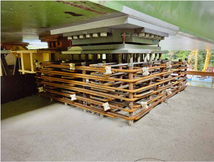
Fix saru szármolyának vasszerelése
