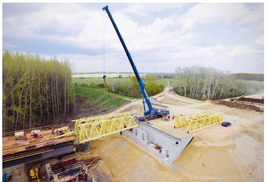
Balpálya szerelőcsőr harmadik tagjának kiemelése
