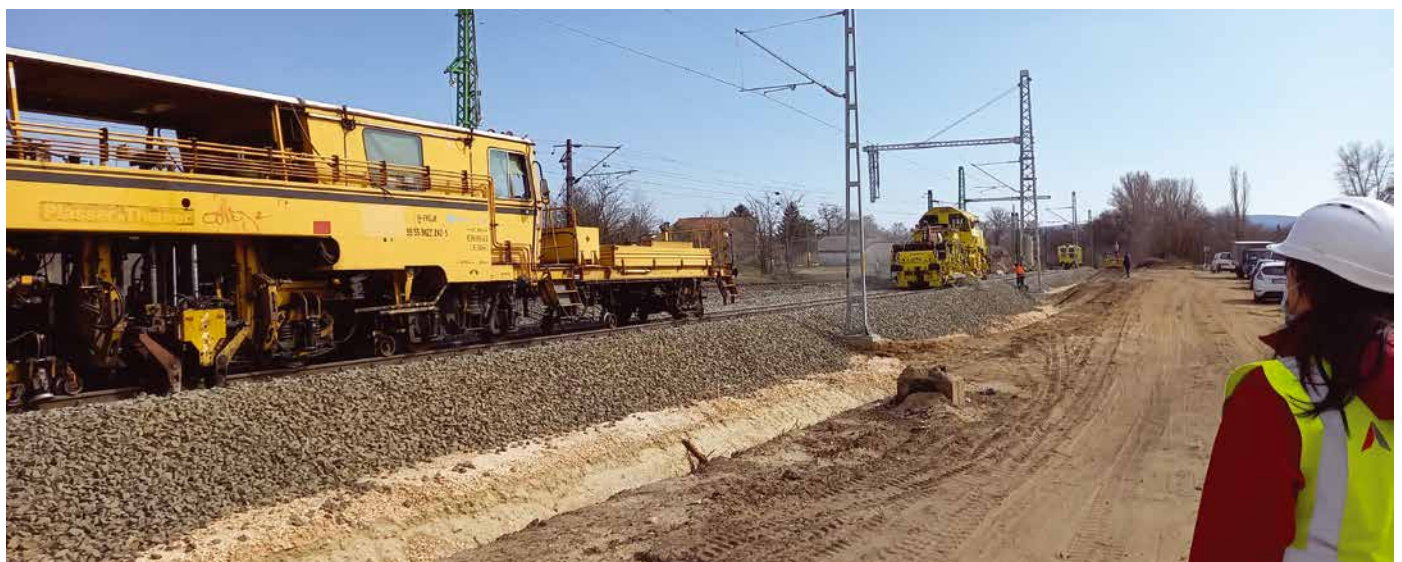
4. kép: Vasúti gépek dolgoznak a nyílt vonalhoz már csatlakoztatott ideiglenes jobb terelővágányon (fotó: Bálega János, A-Híd Zrt.)
