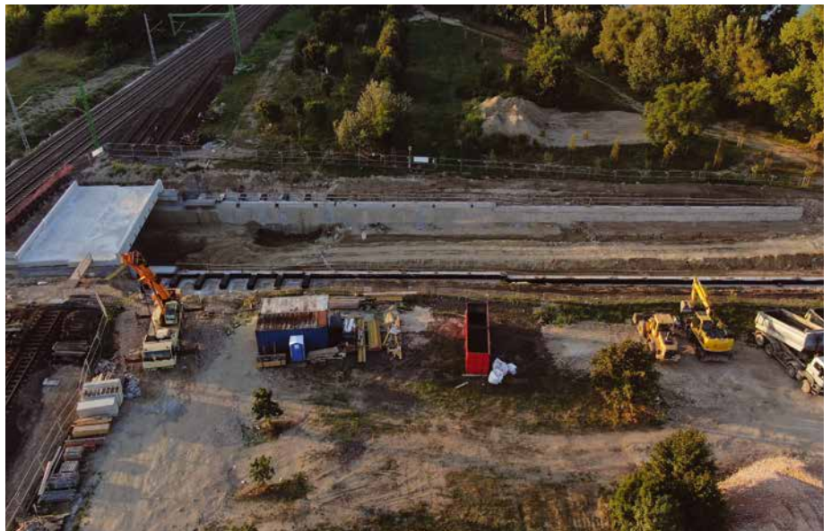
8. kép: A vasúti híd kész szerkezete, tőle jobbra pedig az aluljárót határoló résfalak láthatók, közöttük folyik a föld kitermelése (fotó: Drone Tatabánya)
