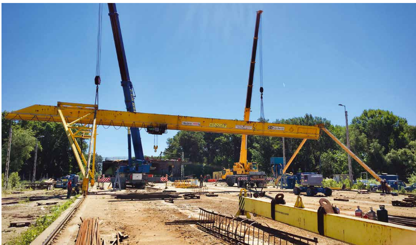
Szerelőtéri bakdaru leengedése
