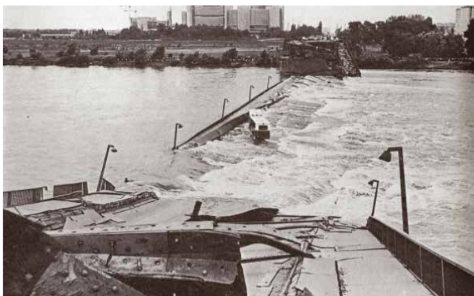
6. ábra: A leszakadt/összeomlott Reichsbrücke Duna-híd látképe 1976. augusztus elsején, a hajnali órákban: A híd szinte teljes egészében a vízben fekszik: az összeomlás pillanatában a hídpályán maradt a bécsi közlekedési vállalat csuklós busza, de a buszsofört sikerült kimenteni. (a háttérben az UNO-City)
