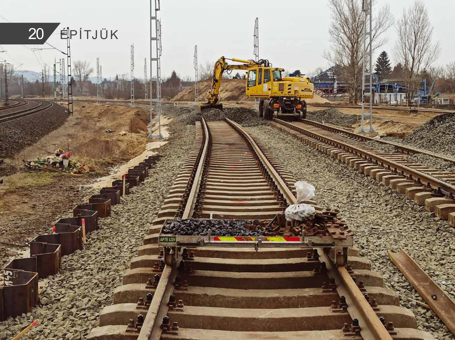
2. kép: Az ideiglenes terelővágányok nagy része vágányzár nélkül megépíthető volt (fotó: Somogyvári Péter, A-Híd Zrt.)
