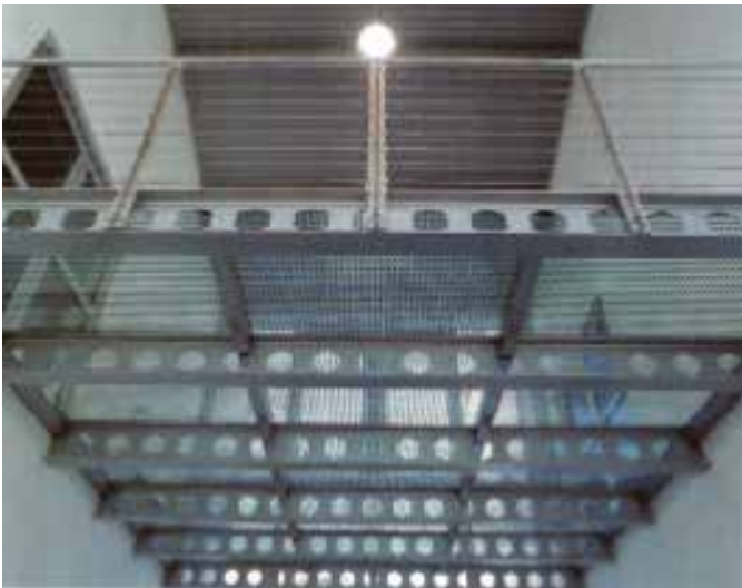
13. ábra: A laborépület épületeit összekapcsoló aláfeszített üveghíd látképe
