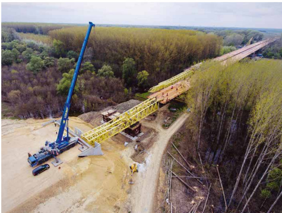
Balpálya szerelőcsőr második tagjának előkészítése emelésre
