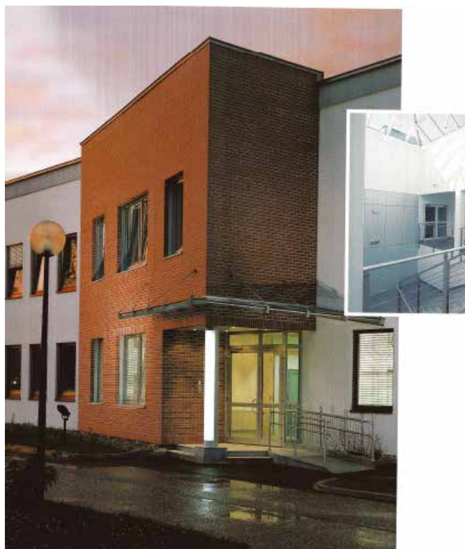
12. ábra: Az Építőanyag, Épületfizikai és Tűzvédelmi laborépület
