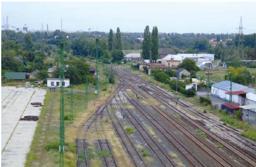
Óbuda vasútállomás jelenlegi állapota
