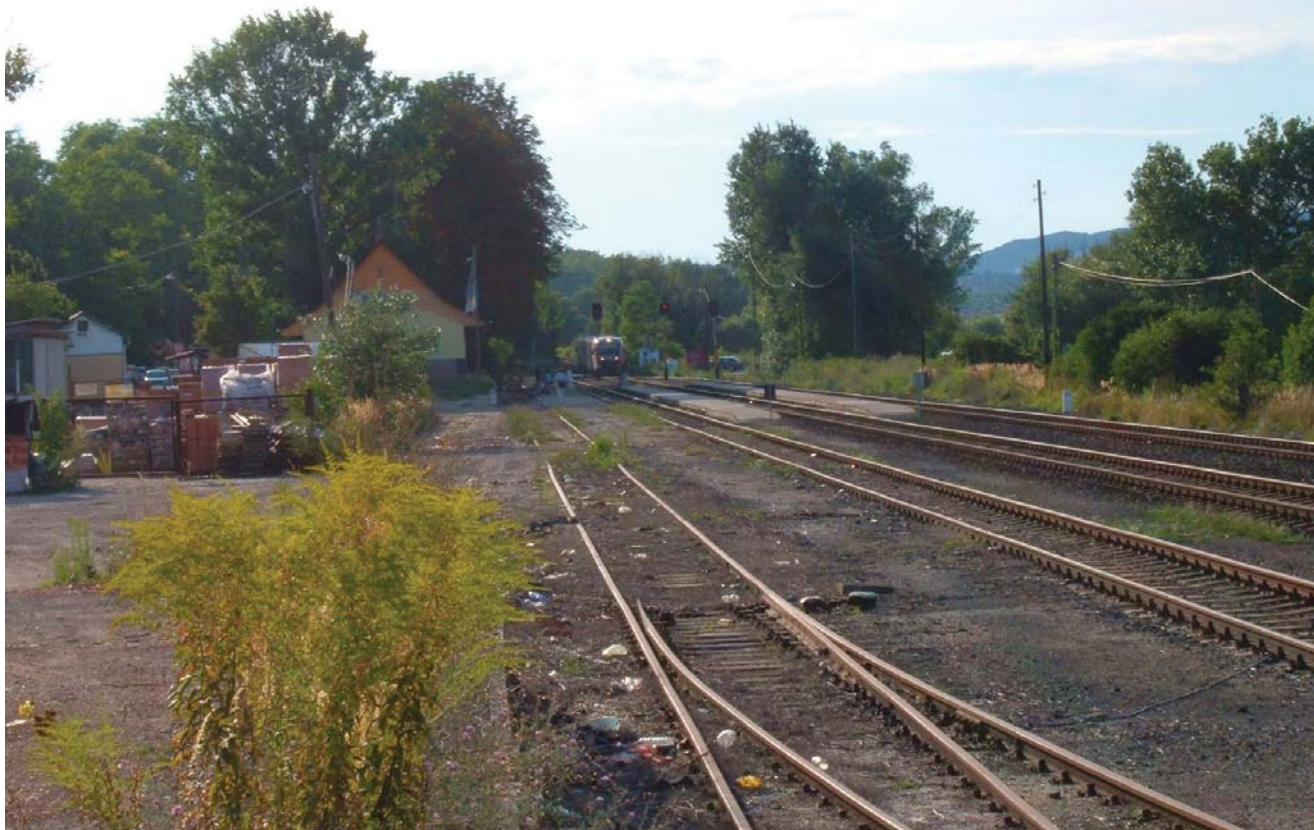
Solymár vasútállomás jelenlegi állapota
